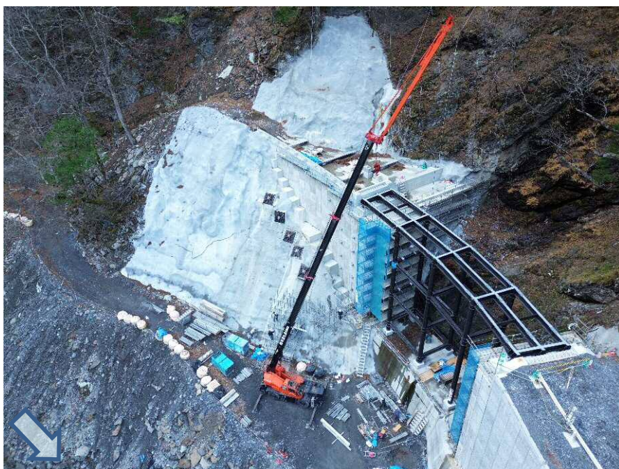
【下流側上空より施工箇所を望む】
