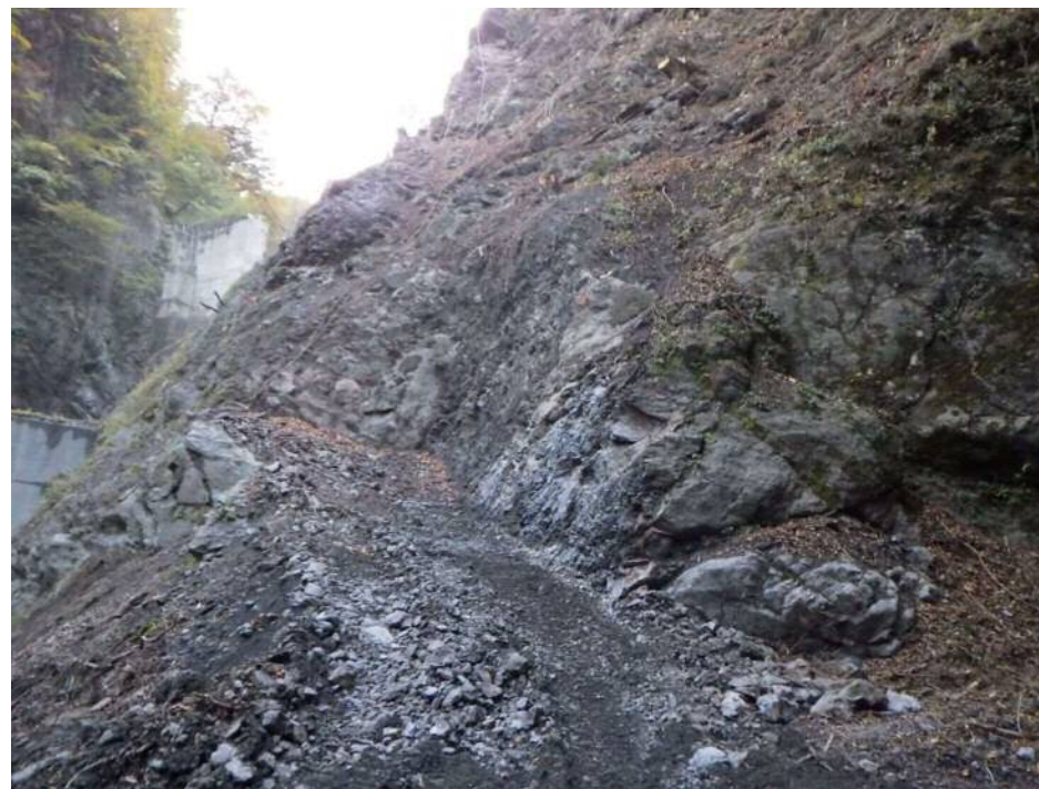
起点側より施工箇所を望む
