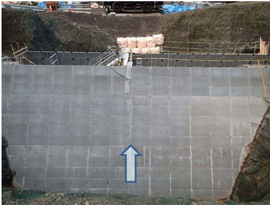
上流側より施工箇所を望む
