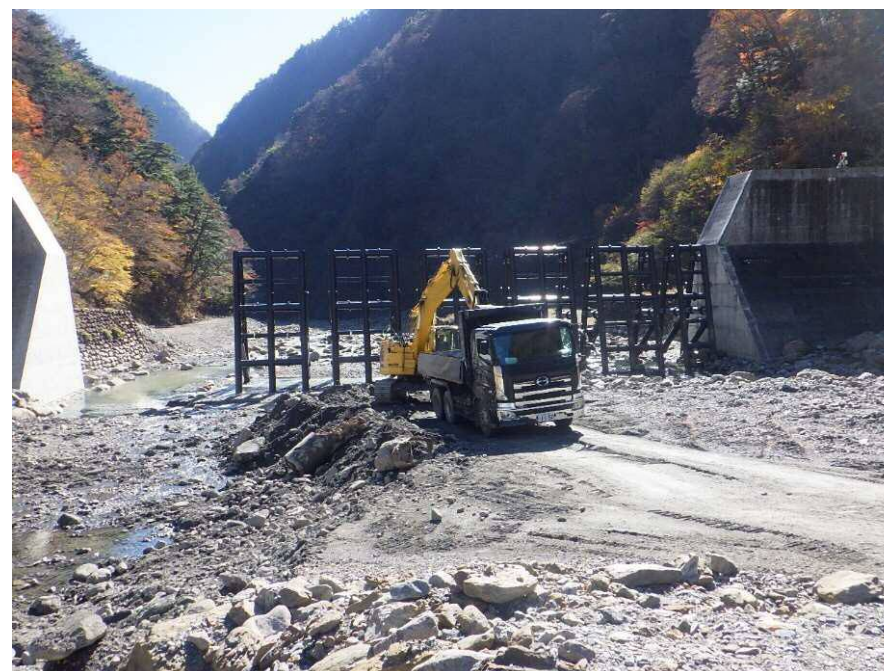
【仮締切り撤去 施工状況】
