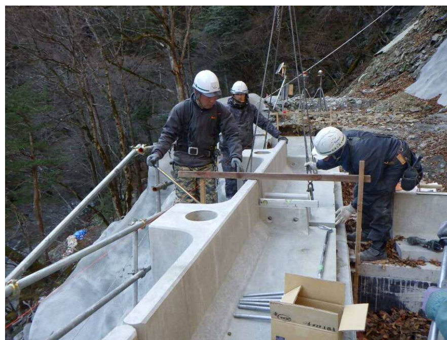
【防護柵基礎設置状況】
