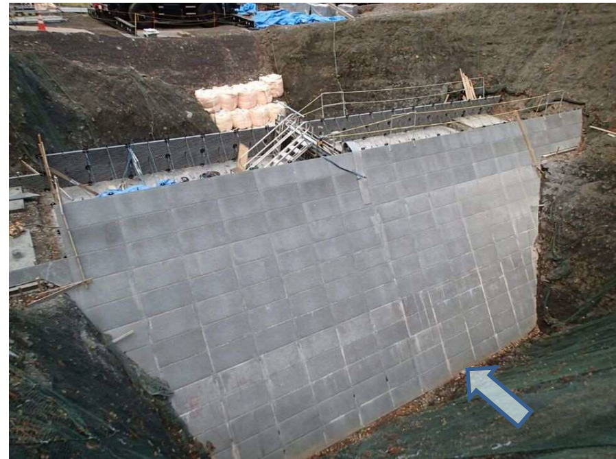
左岸側上流より施工箇所を望む
