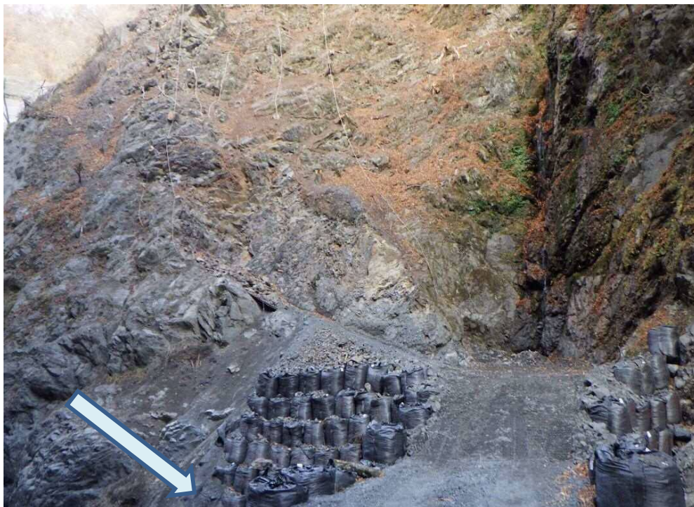
右岸側より施工箇所を望む
