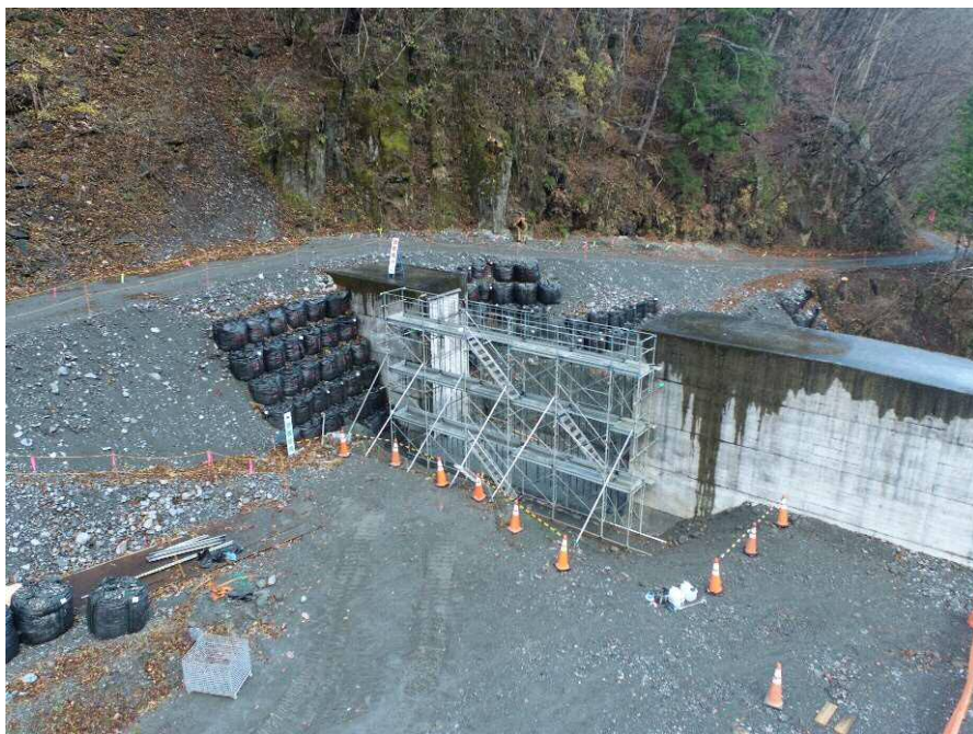
【上流側上空より施工箇所を望む】
