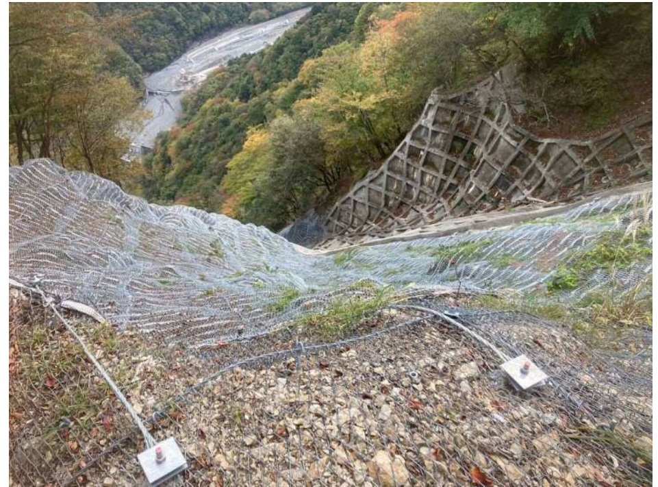
雪害防止網工(厚ネット)完了
