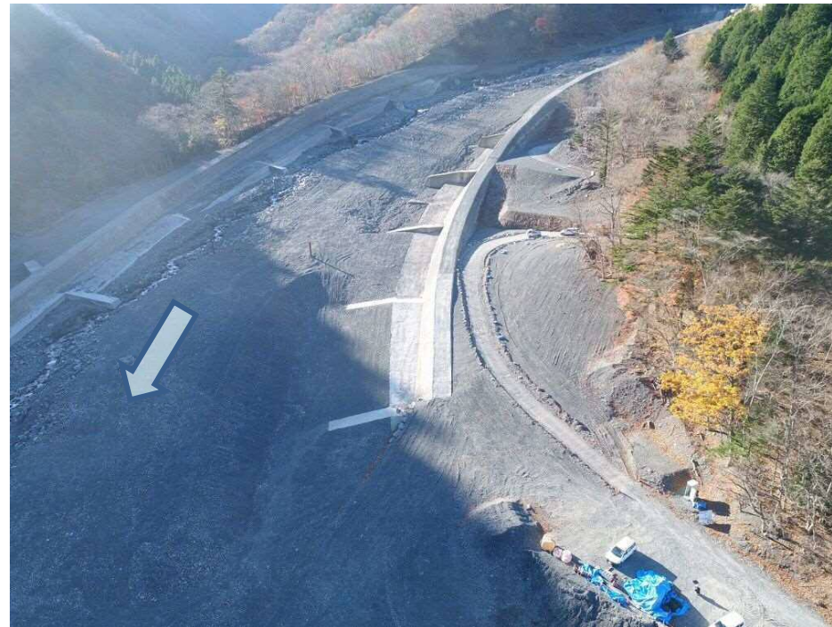
大春木工区 下流側上空より望む
