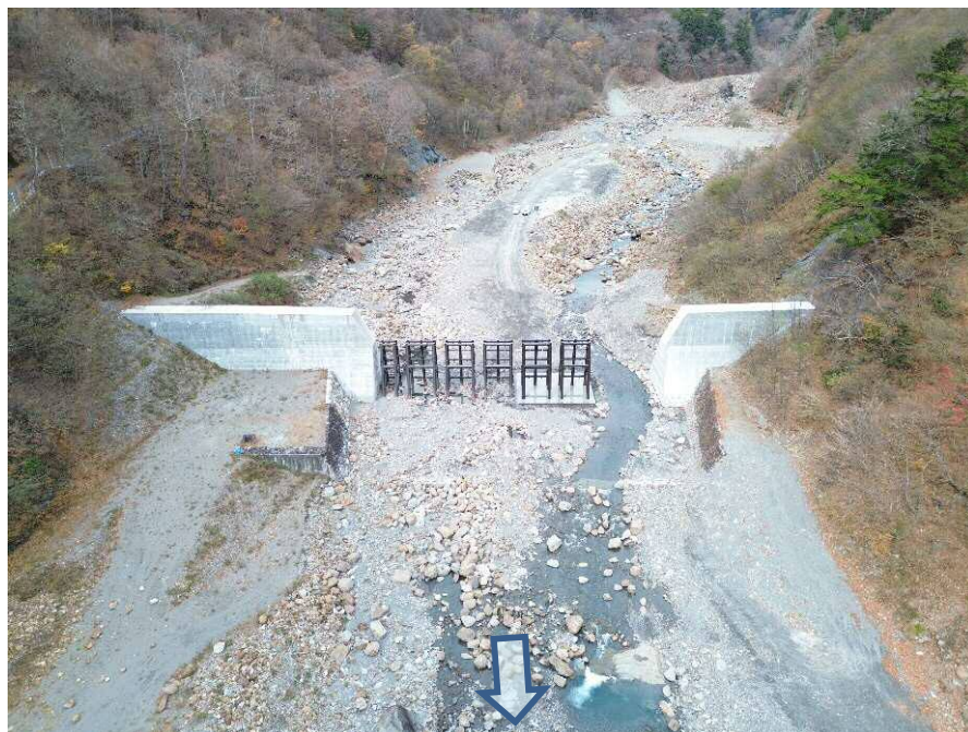
【下流側上空より施工箇所を望む】
