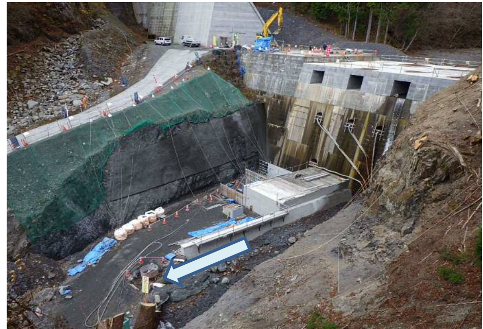
左岸側より望む
