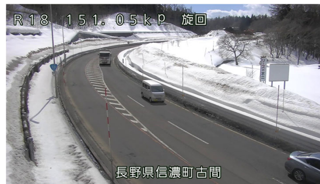
CCTVカメラ画像
