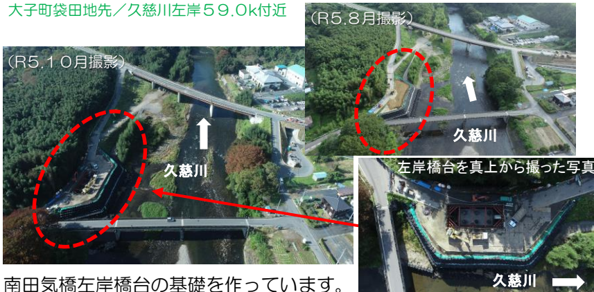
南田気橋左岸橋台の基礎を作っています。
