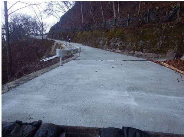
舗装工施工状況【中川地区】
