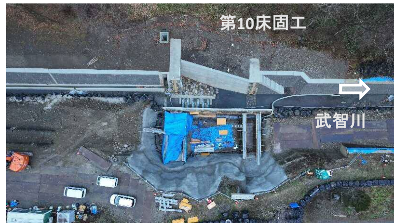
↑ 上空より施工箇所（第10床固工）を望む
