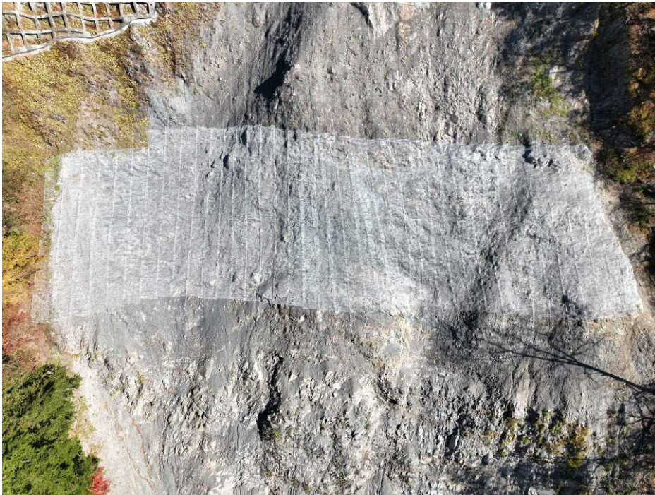
落石防止網工 施工完了
