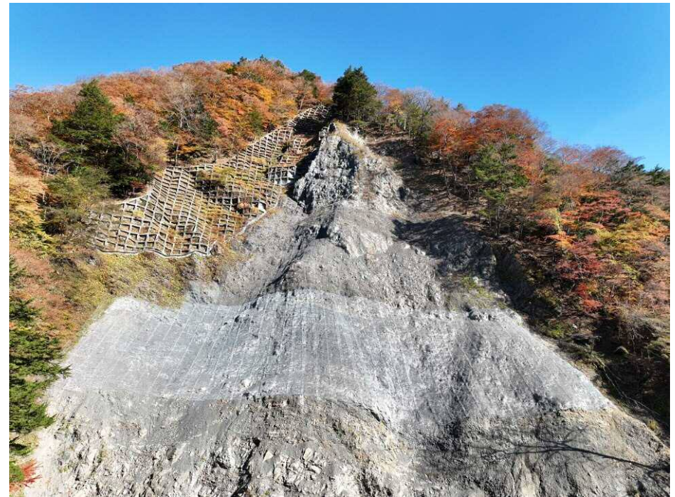
落石防止網工 施工完了
