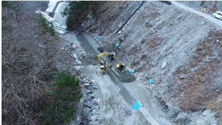
路体盛土施工状況【I地区：中島砂防堰堤下流】
