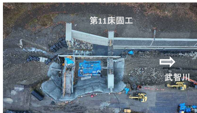
↑ 上空より施工箇所（第11床固工）を望む
