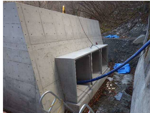
擁壁工施工状況【I地区：中島砂防堰堤下流】
