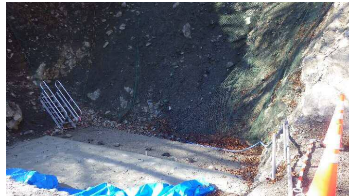
擁壁工施工状況【J地区：中島砂防堰堤上流】
