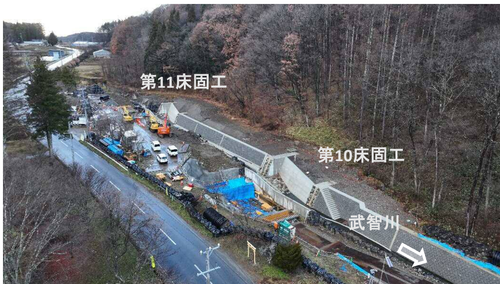
右岸上空より施工箇所を望む
