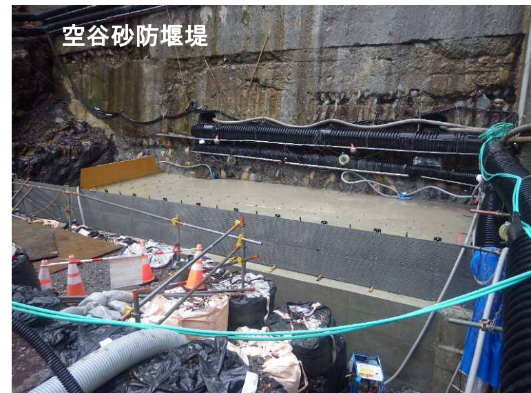
コンクリート堰堤（腹付け）施工状況
