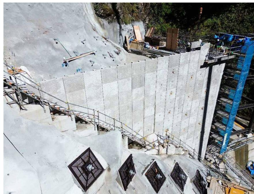
【軽量盛土工 施工状況（壁面材設置）】
