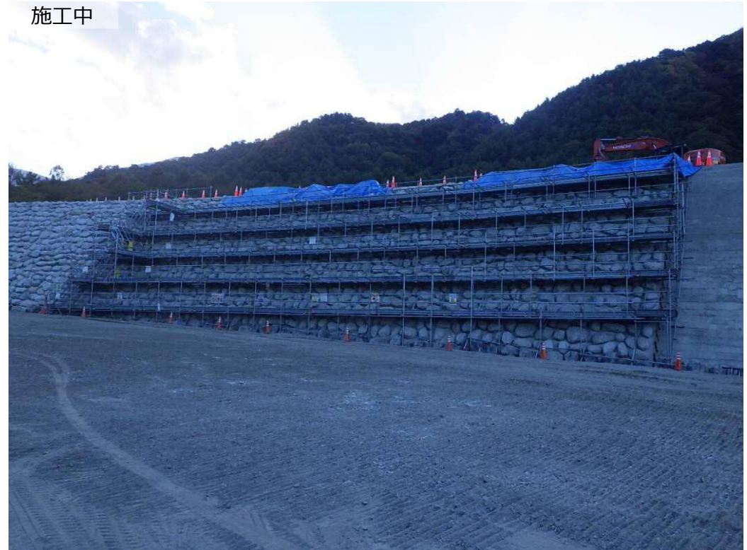
多自然型護岸工（巨石積）
