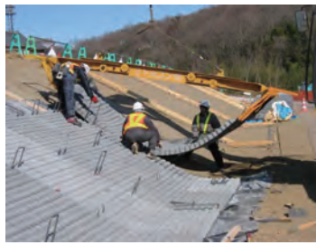
ブロックマットを設置しているようす
