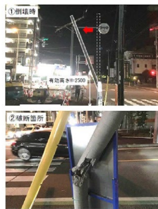
事故発生状況写真
