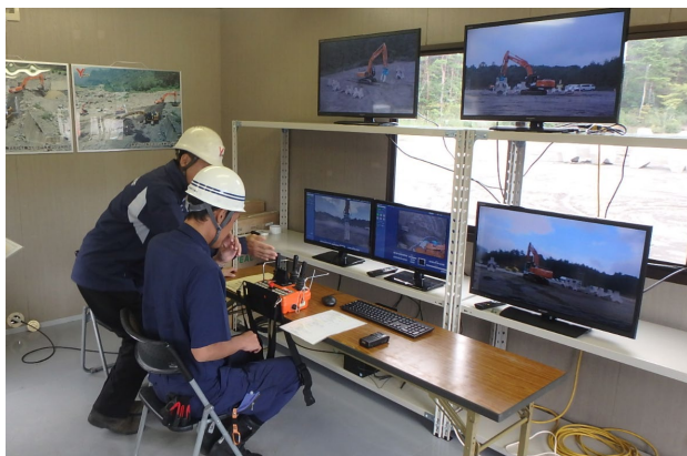
グラップル付バックホウ根固設置（操作）
