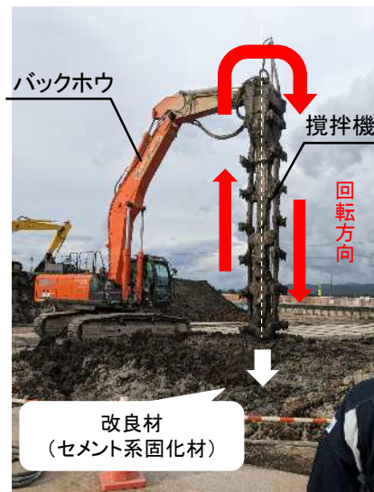
地中に入れ、水平方向にN字に動かします。
