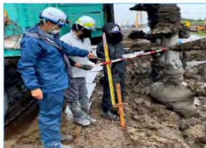
【立会状況（現場側）】
