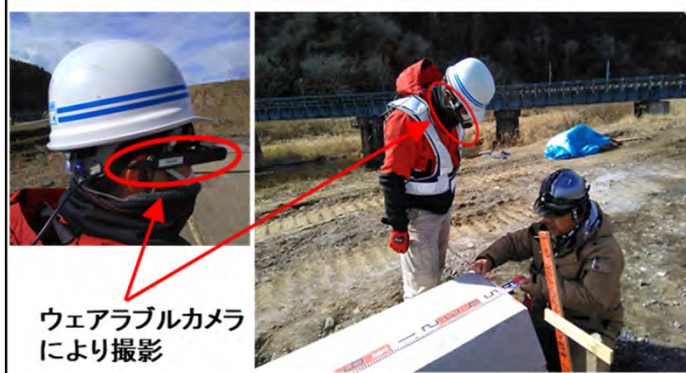
現場での受注者による撮影状況
