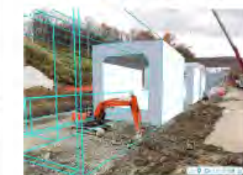
掘削作業時にARと比較
