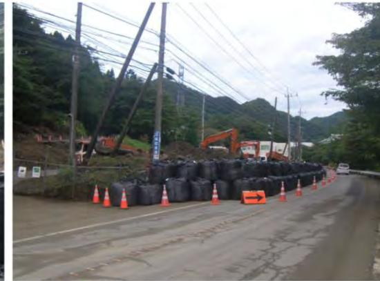
道路上の土砂を撤去し大型土のうを設置。
