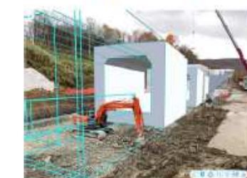
掘削作業時にARと比較
