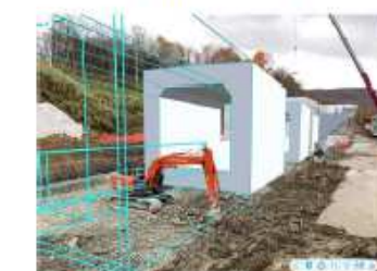
掘削作業時にARと比較
