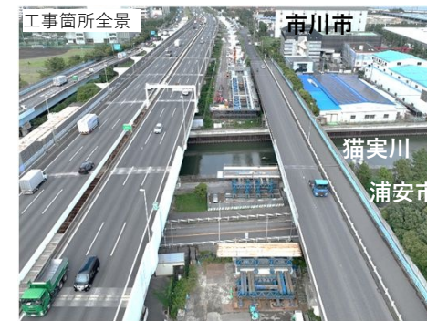
7.1m浦安側へ橋桁を移動させました
