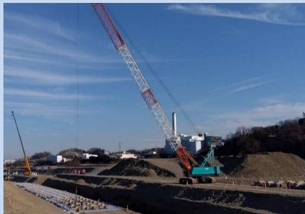
護岸ブロック、根固めブロックを設置しています。 (令和6年1月)
