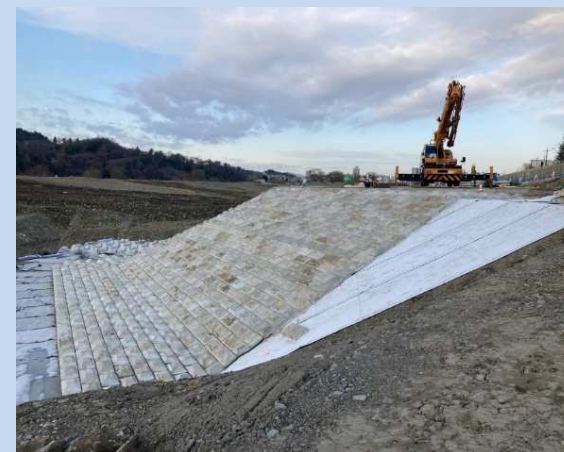
護岸ブロックを設置しています。 (令和6年2月)
