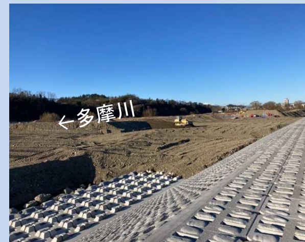
根固めブロックを設置しています。 (令和6年2月)
