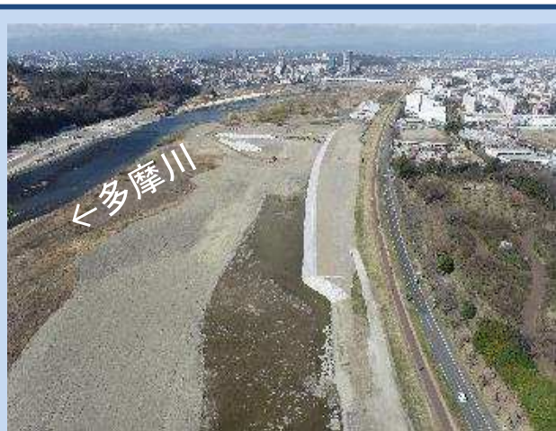
工事が完了しました。 (令和6年3月)
