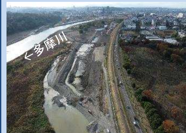
仮締め切りを施工しています。 (令和5年11月)
