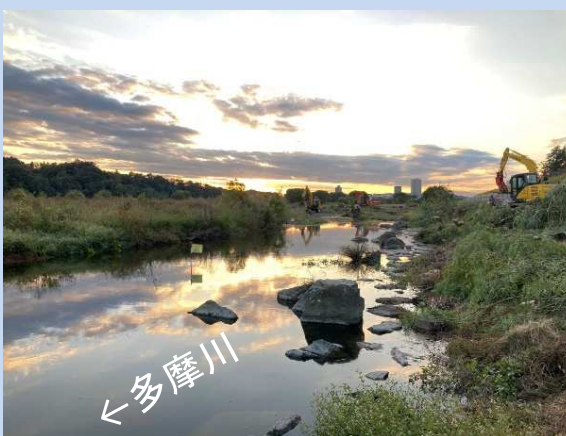
工事に入る準備をしています。 (令和5年10月)
