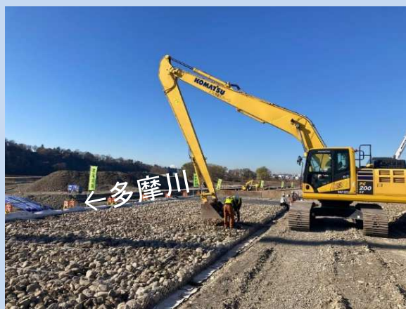
プレキャスト基礎ブロック、かごマットを設置しています。 (令和5年12月)
