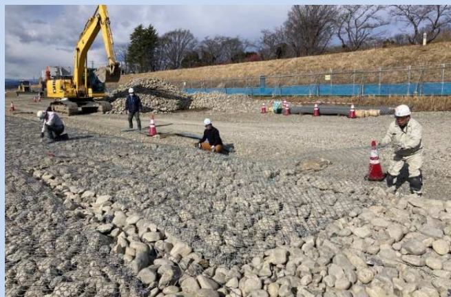
護岸ブロック、かごマットを設置しています。 (令和6年1月)
