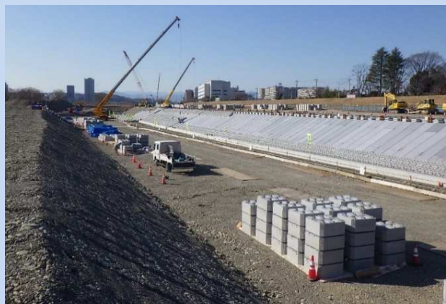
護岸ブロック、かごマットを設置しています。 (令和6年1月)
