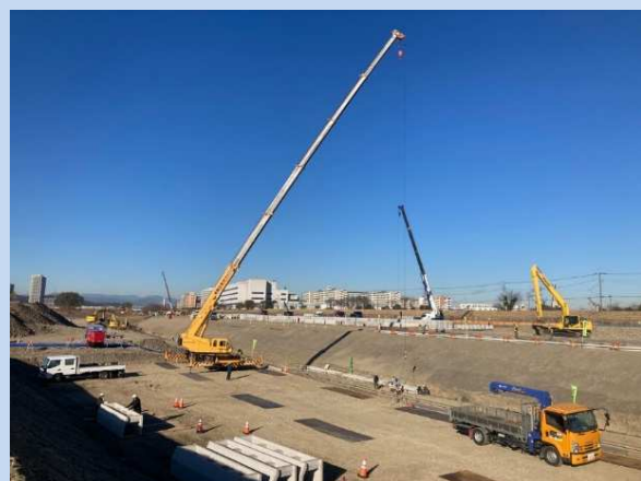
プレキャスト基礎ブロック、かごマットを設置しています。 (令和5年12月)
