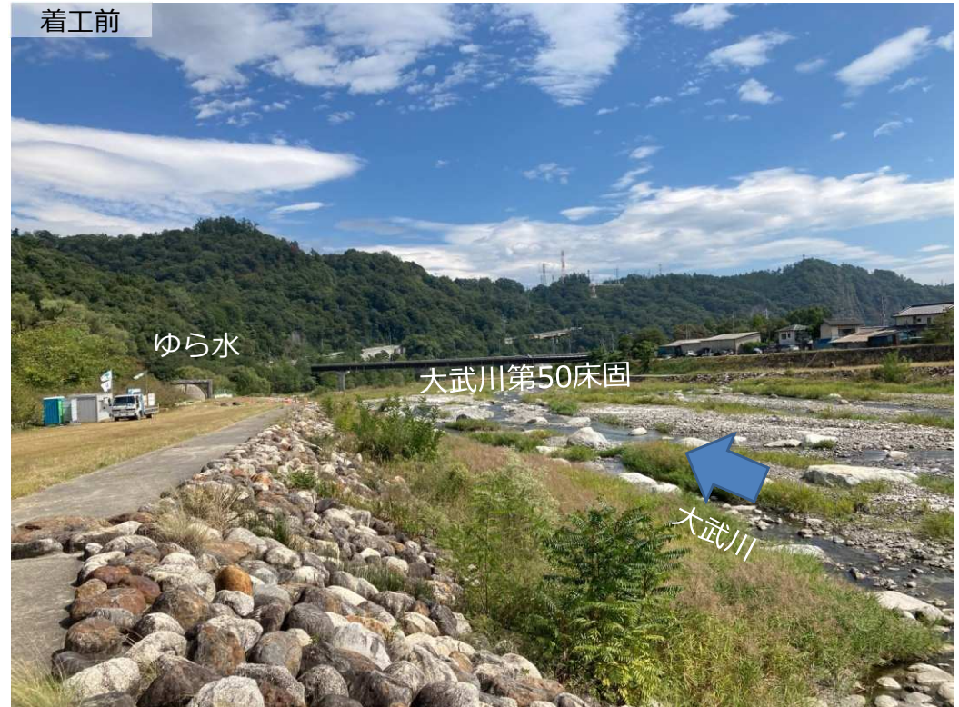
上流側より下流
