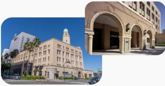
横浜税関本関 (平成15年度改修及び増築工事竣工)
