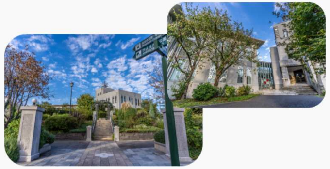
横浜地方気象台 (平成20年度改修及び増築工事竣工)
