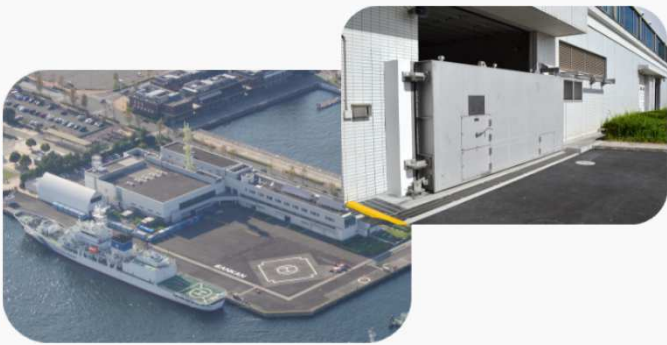
横浜海上防災基地 (平成6年度竣工)
