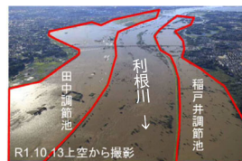
【遊水地への湛水状況】
