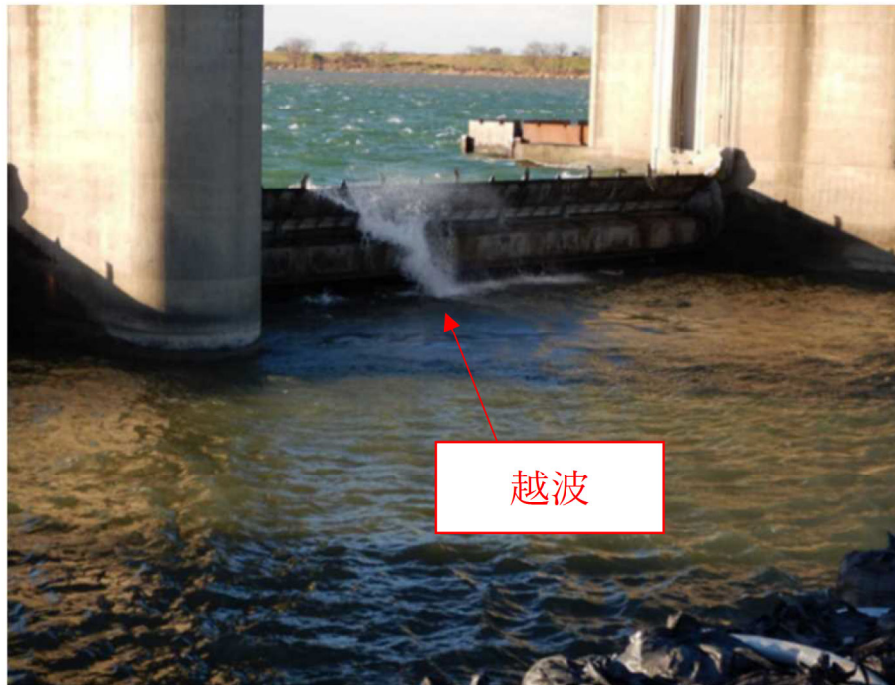
利根大堰左岸の越波と水たまりの状況（令和3年1月）
