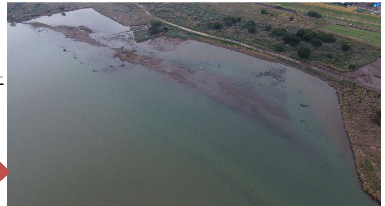
出水直後の状況(2017年10月28日撮影(Y.P.17.3m) (台風による降雨は10月18~23日)
