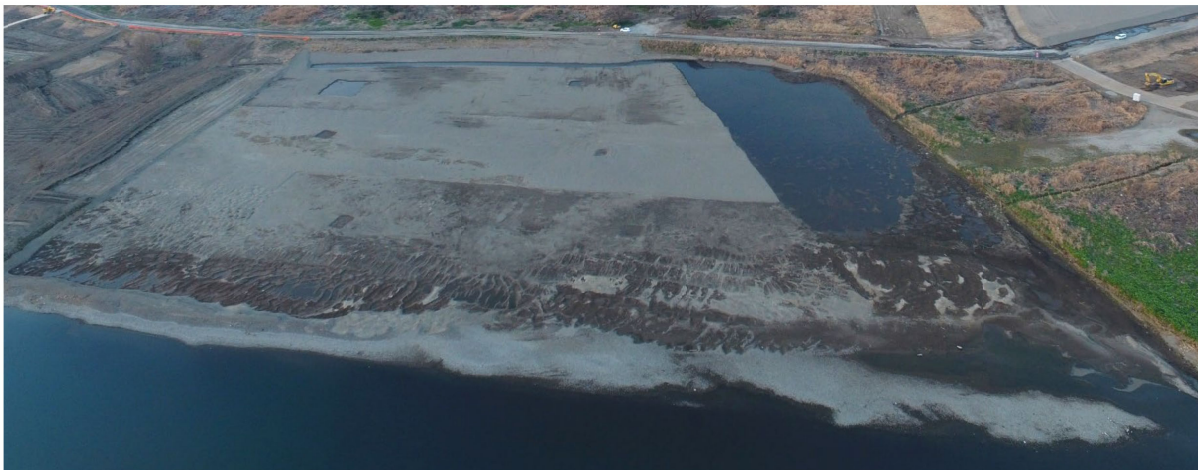
2016/12/12撮影 ※川俣水位:Y.P.16.3m ※掘削完了直後(だるま池は改善掘削前)
