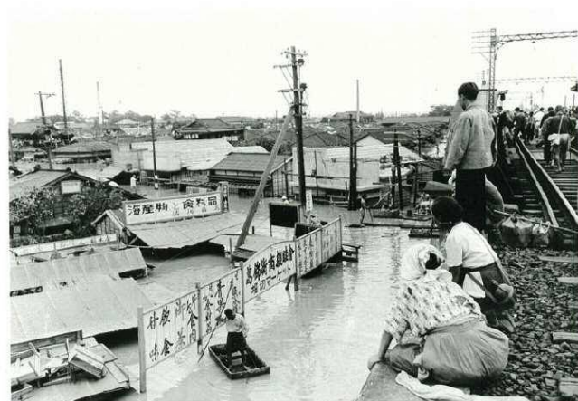
葛飾区の浸水状況
