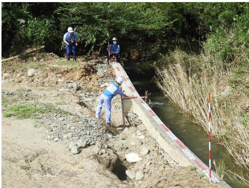
被災状況調査(河岸洗掘)
