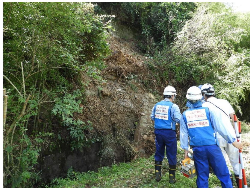
被災状況調査(河道閉塞)
