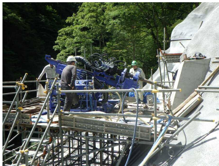
【グラウンドアンカー施工状況】
