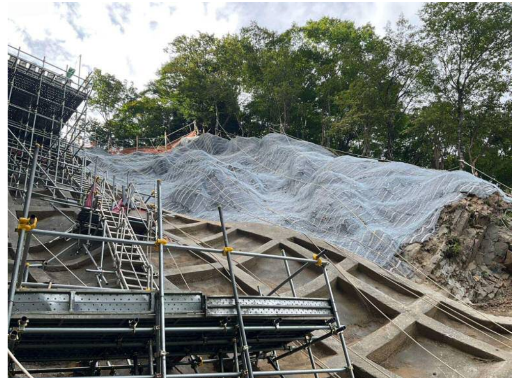
雪害防止網工(厚ネット)施工状況
