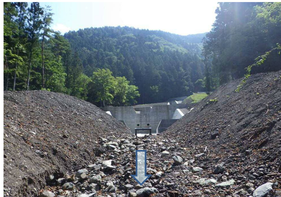
下流側より施工箇所を望む
