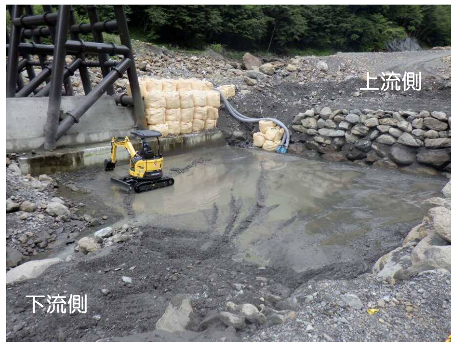
【水通し部の掘削状況】
