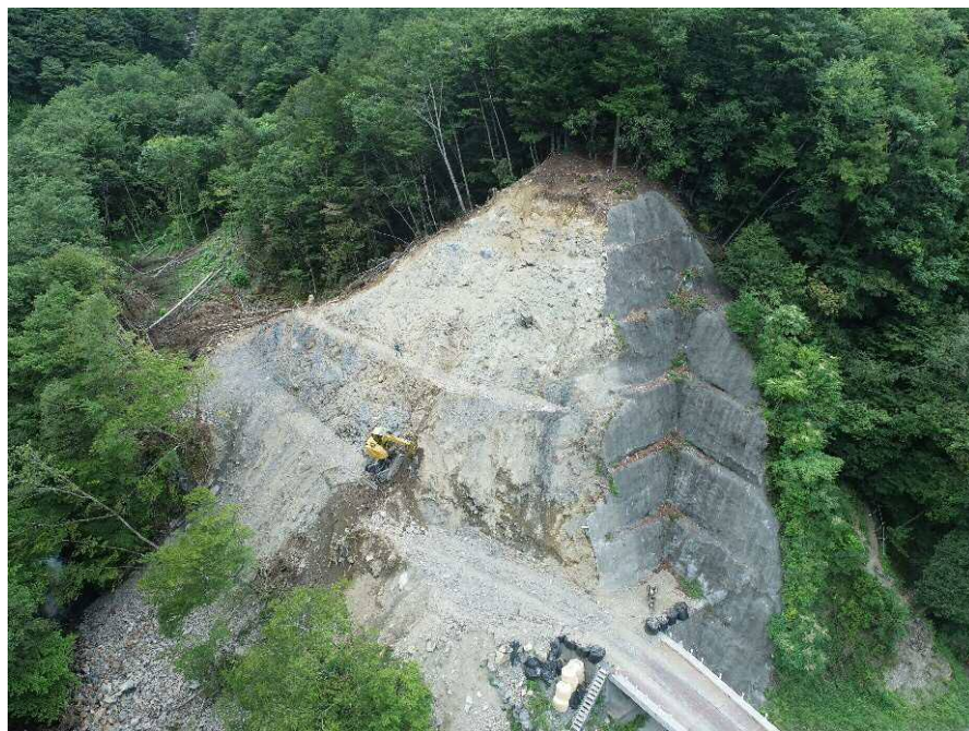
【上空より施工箇所を望む】
