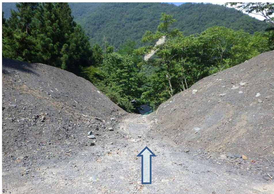
上流側より施工箇所を望む
