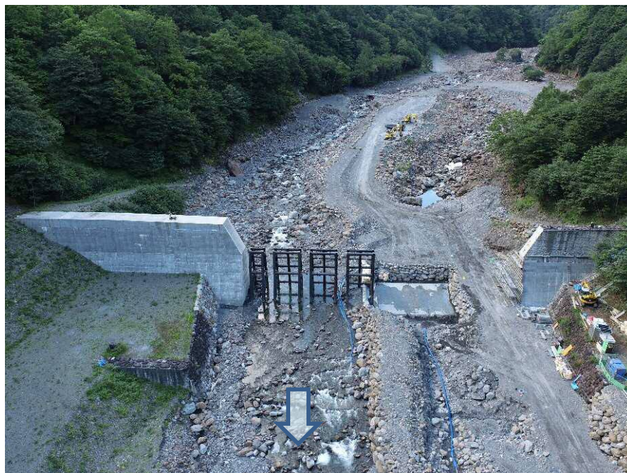
【下流側上空より施工箇所を望む】
