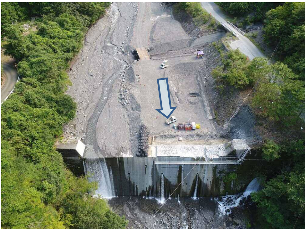
仲島工区 下流側上空より望む
