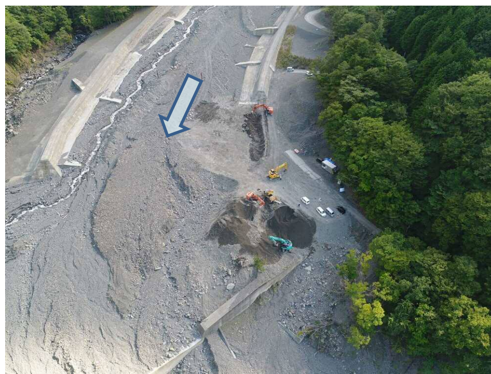
大春木工区 下流側上空より望む
