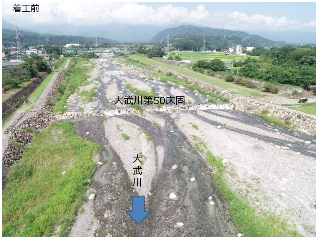
下流側より上流
