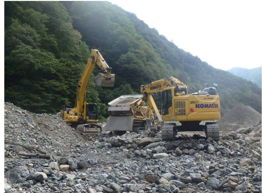
工事用道路 盛土材採取状況 （釜無川砂防堰堤上流）
