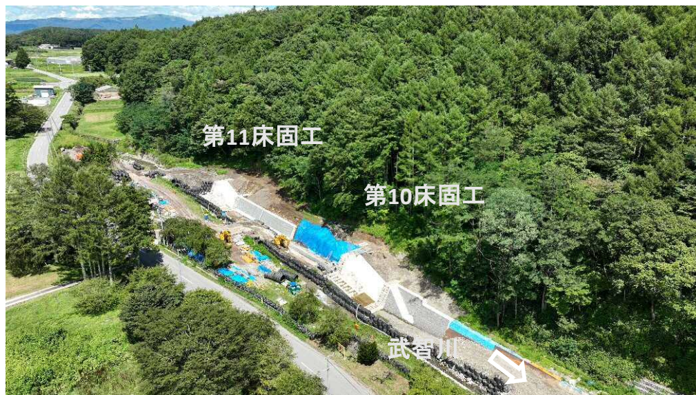
下流上空より施工箇所を望む
