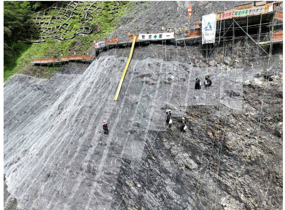
落石防止網工 施工状況
