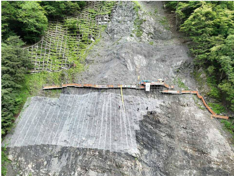
上空より施工箇所を望む
