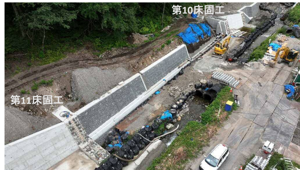
流路護岸工 施工状況
