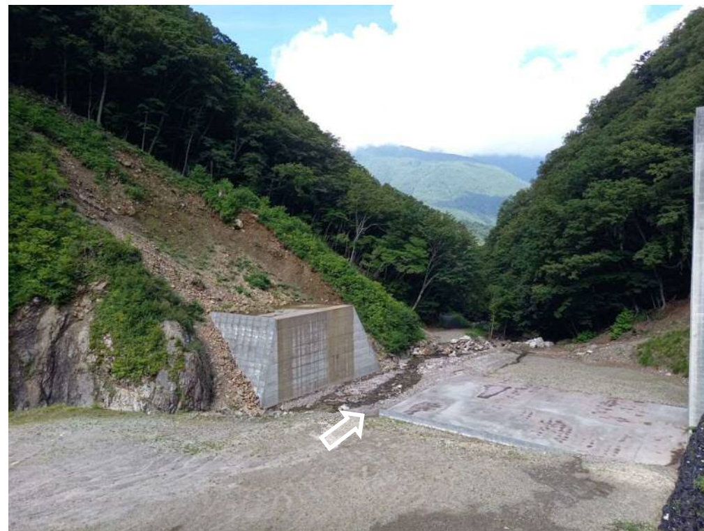
上流 右岸より本堰堤を望む（コンクリート堰堤工）
