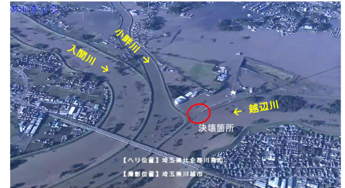
越辺川での決壊状況
