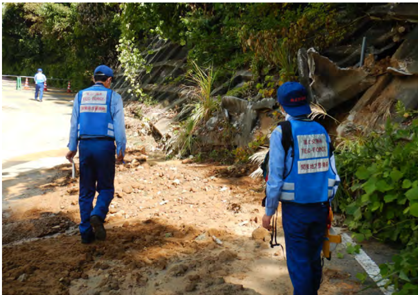
被災状況調査(北茨城市中郷町地先)
