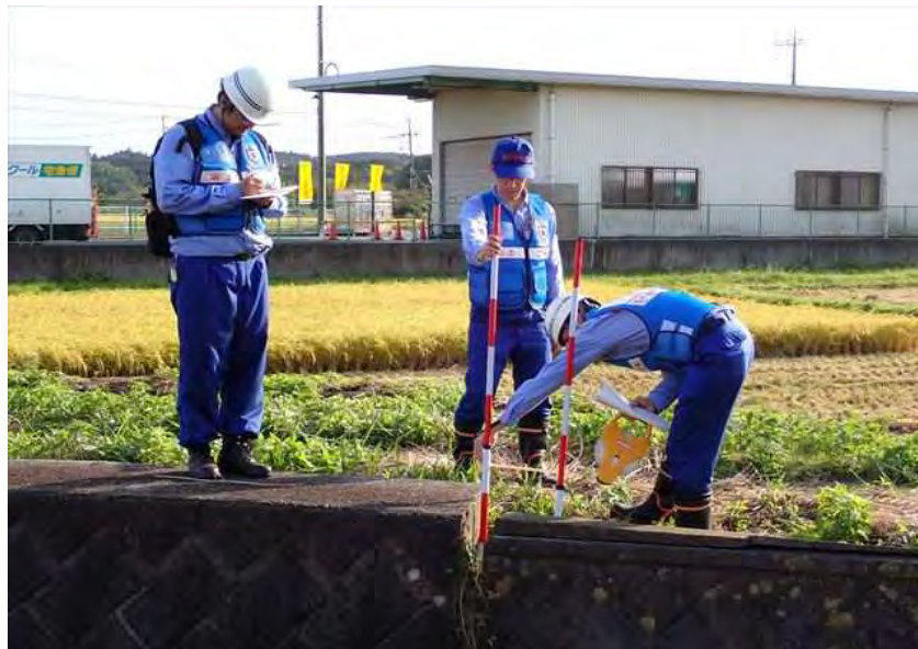
被災状況調査(茨城県北茨城市/相田川)
