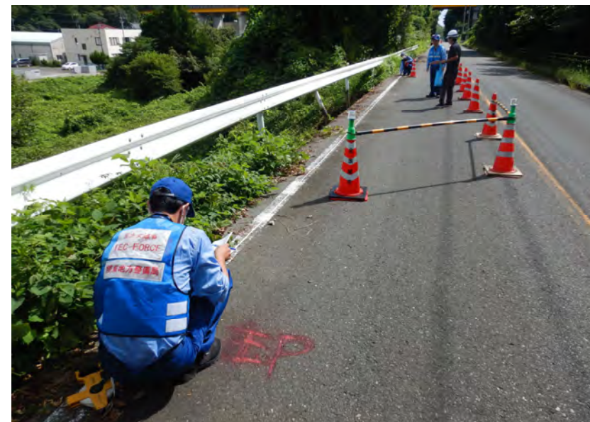
被災状況調査(北茨城市中郷町地先)
