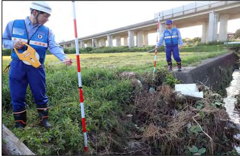
被災状況調査(茨城県北茨城市/天橋川)
