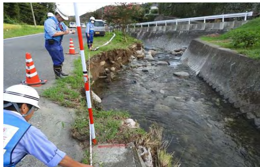
被災状況調査(茨城県北茨城市/峰岸川)
