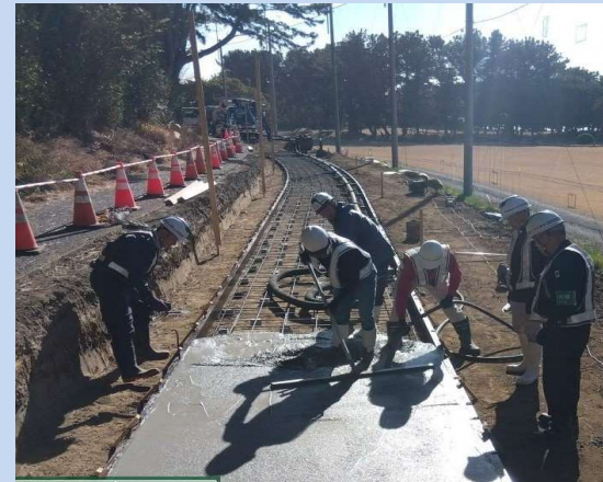
基礎コンクリート打設を行っています。 (令和6年1月)
