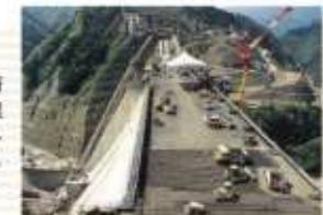
▲RCDコンクリート施工(平成5年)
