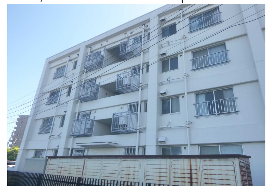
④外観(給湯設備)
