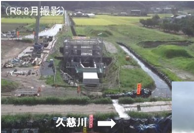
R 3 久慈川左岸塩原用排水樋管改築工事 / (株) 新井組
