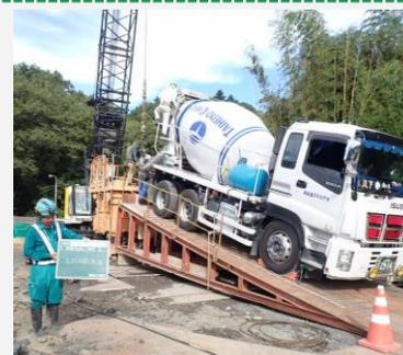
③コンクリートを打設します。仮設ケーシングを抜いてコンクリートが固まれば杭の完成です。
