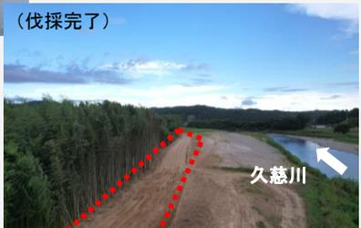
洪水の流れをよくするため、樹木や竹の伐採をしています。今後、河道掘削に着手します。
