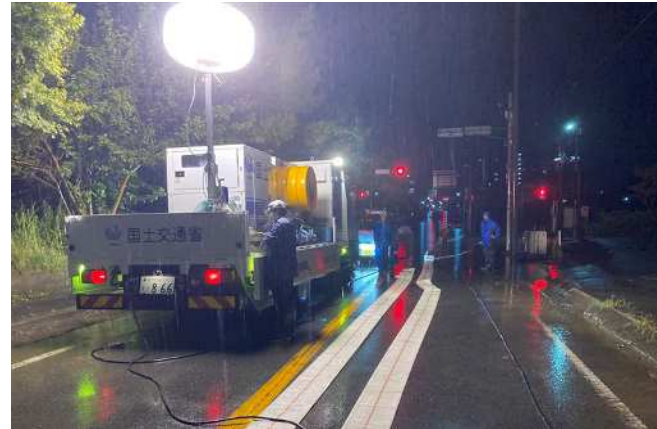
道路冠水箇所での排水活動
