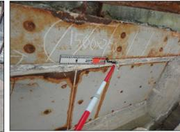
【補強鋼板の浮き・腐食】
