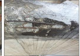
【アーチ肋の剥離・鉄筋露出】
