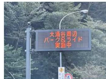
横浜国道事務所管轄情報板 【箱根新道山崎旧料金所付近】
