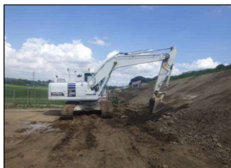
MC（マシンコントロール）建設機械による 法面整形の施工状況
