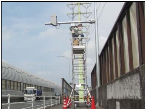
■CCTVカメラ（設置状況）
