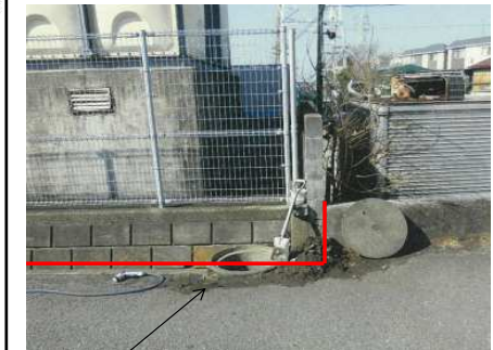
⑤排水枡部分が隣地に越境している
