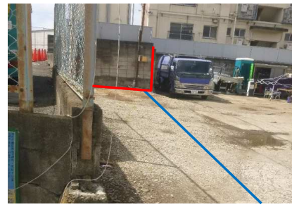
③産廃業者が使用、受水槽擁壁が越境
