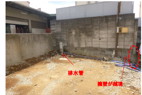
④受水槽擁壁部
