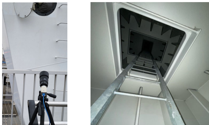
図-1 主塔における鉛直移動と内部の狭あいな環境
