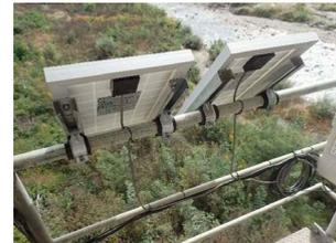
図8 送信機の太陽電池パネル設置状況
