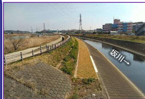
R3松戸管内河川管理施設補修工事 【流山地区の護岸補修】
