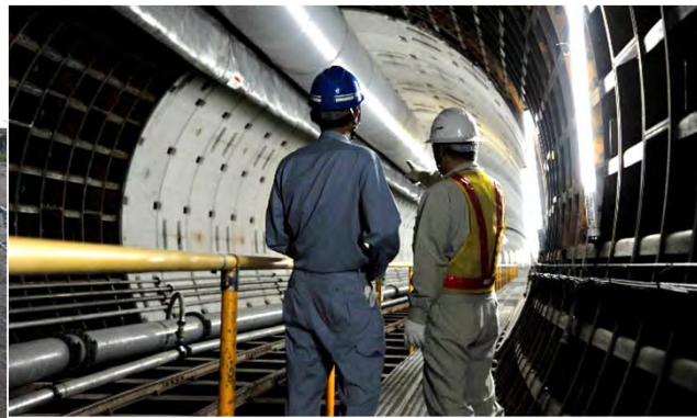
雨水貯留管の整備
