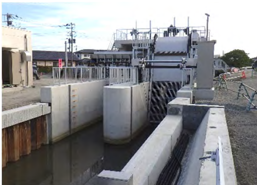
雨水ポンプ場の整備
