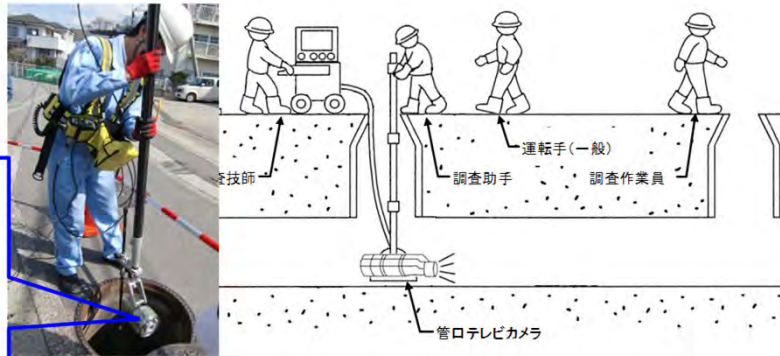
計画的な点検・調査
