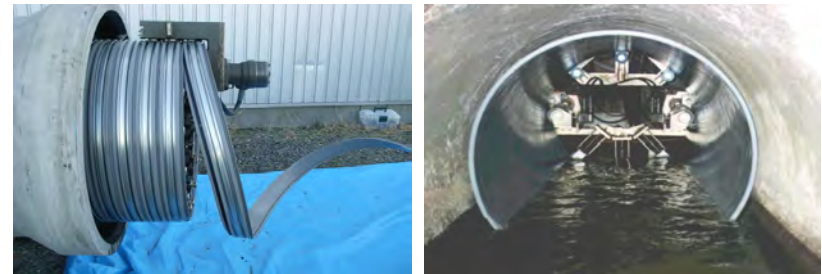
計画的な改築・更新(管路の更生工法)
