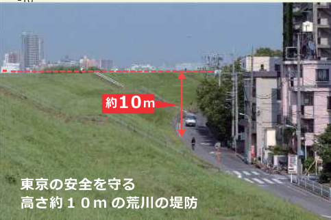
東京の安全を守る高さ約10mの荒川の堤防
