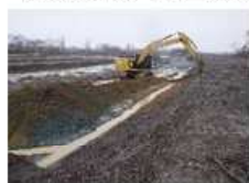
河道掘削 (石狩川水系、北海道開発局)
