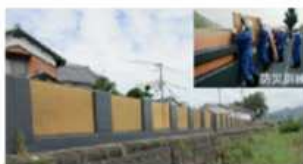
自主防災活動による堤防設置 (揖保川水系、たつの市)
