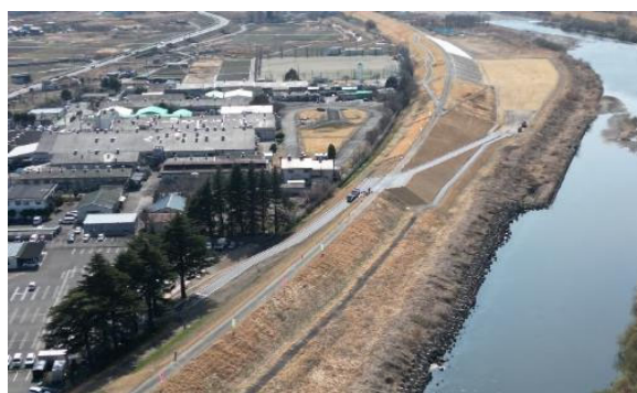
完成(高田工区)
