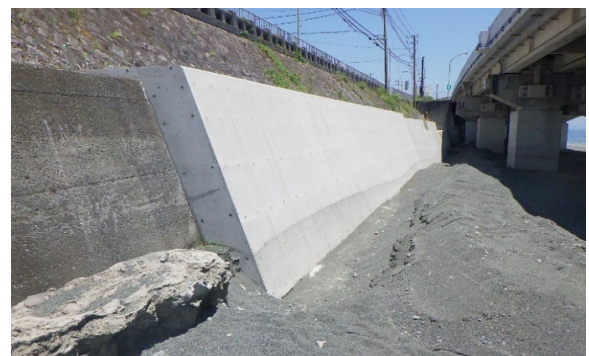
波返し基礎工完成
