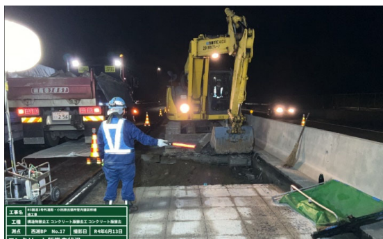
舗装版掘削施工状況
