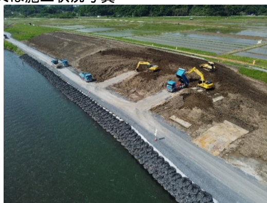
築堤盛土施工状況
