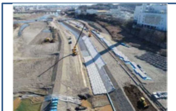
護岸・根固め施工状況
