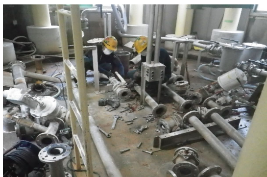
工場内配管施工状況
