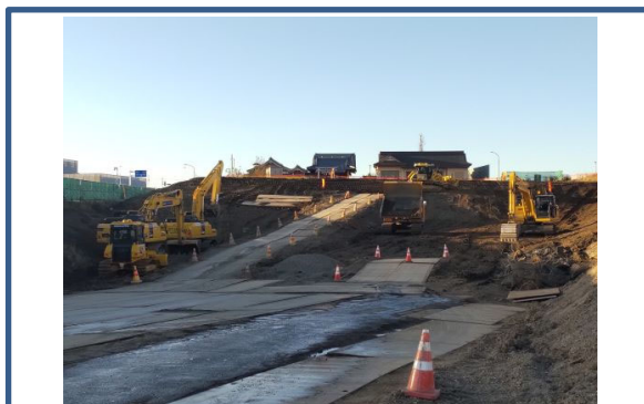
築堤盛土施工状況
