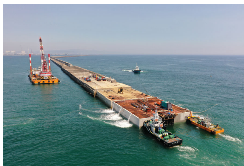
ケーソン据付施工状況
