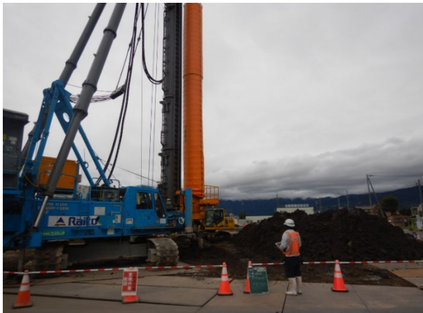
ICT活用工事(地盤改良工)全景
