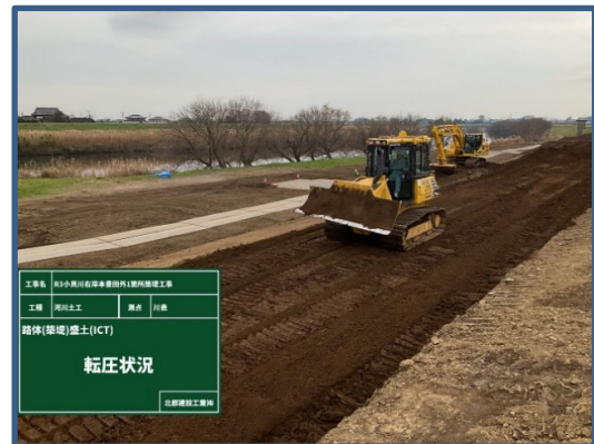
ICT建機による盛土工(転圧)の施工状況
