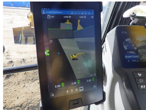
法面整形 ICT建機の確認モニター
