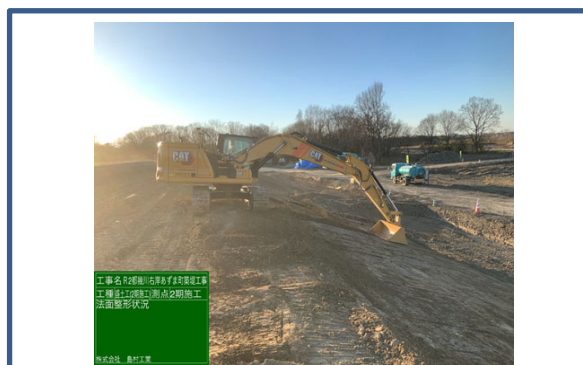
盛土工施工状況
