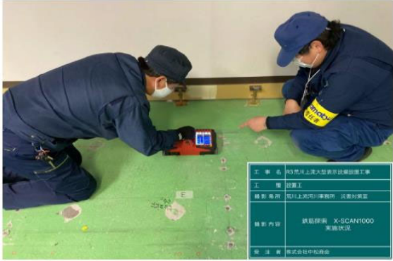
鉄筋探索実施状況
