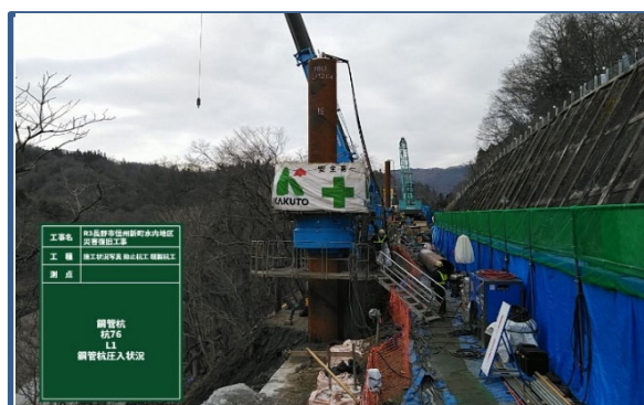
鋼管杭施工状況(昼夜作業)
