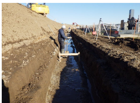
コンクリートブロック工 施工状況
