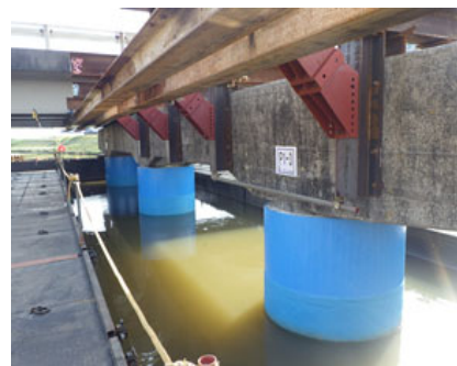
橋脚部 施工完了状況
