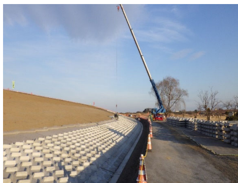
護岸ブロック敷設 施工状況
