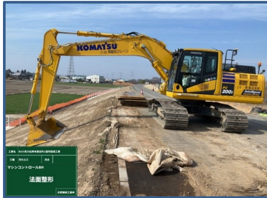
ICT建機による法面整形の施工状況
