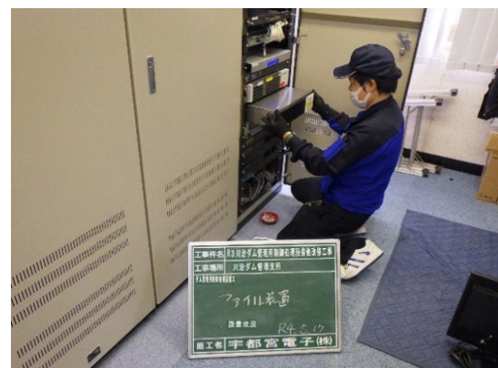
機器設置状況
