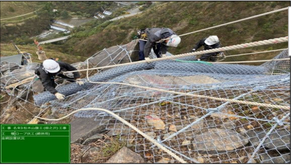
急峻な斜面での施工状況 ・ロープ伏工
