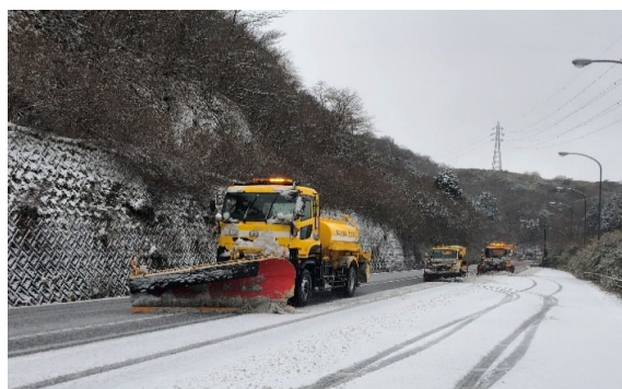
除雪施工状況
