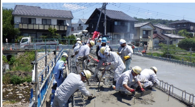
床版コンクリート打設状況(霊亀橋)
