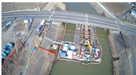
フロート台船からの施工状況
