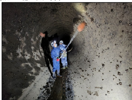
導水管管内付着物撤去状況
