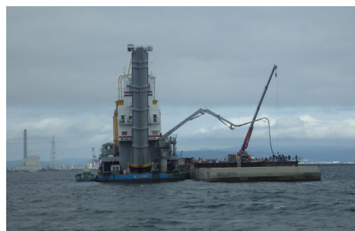
ミキサー船による上部工施工状況
