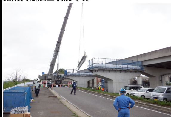
200tクローラークレーン施工状況
