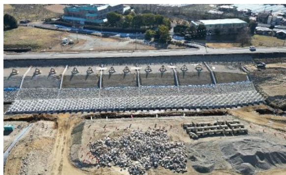
護岸工施工状況(田中工区)
