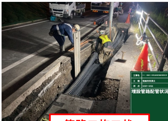
管路工施工状
