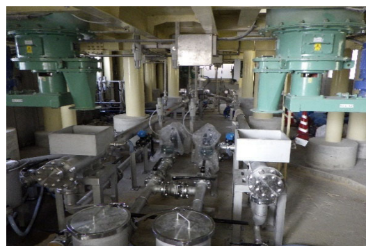
配管施工完成
