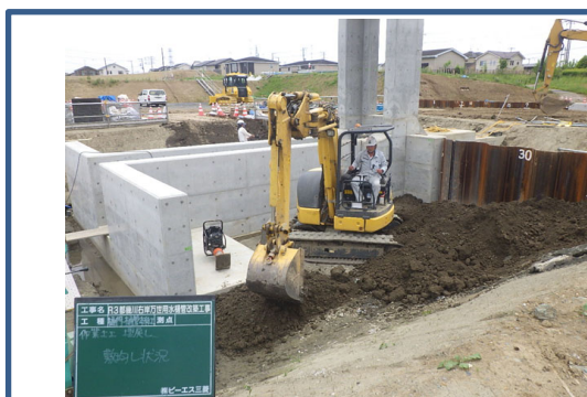
樋管本体工施工状況
