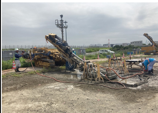
ドリリングマシンによる斜削孔状況
