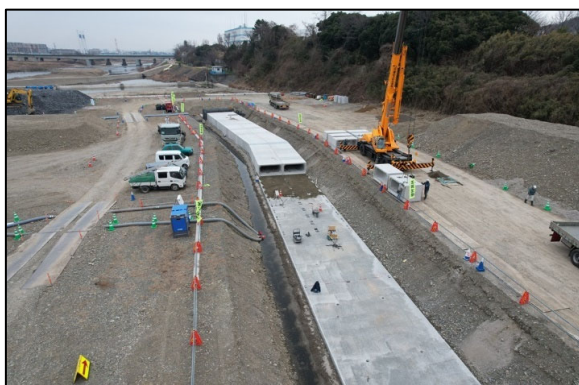
水路工施工状況
