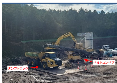
砂防ソイルセメント積込み状況
