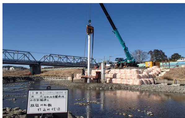
H形鋼打込状況(足利水位観測所)
