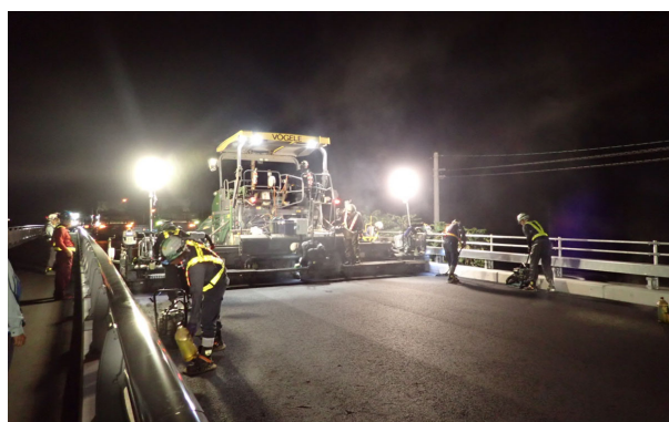
神流川橋舗装施工状況
