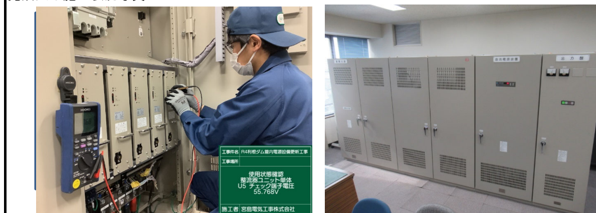
完成又は施工状況写真
