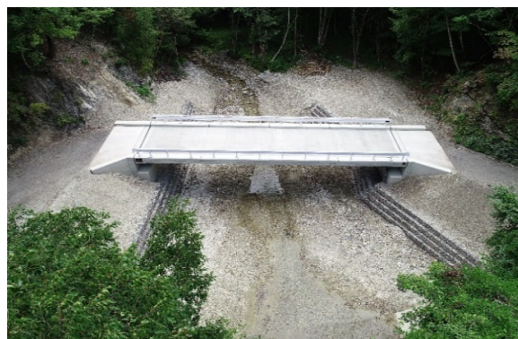
完成(白倉沢橋)
