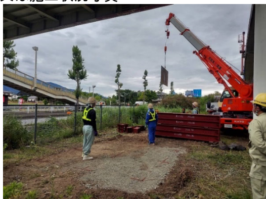
仮バント設置施工状況
