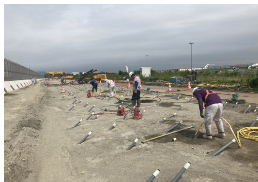
薬液注入施工状況
