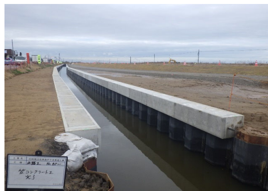
完成(川裏の鋼矢板式堤脚水路)
