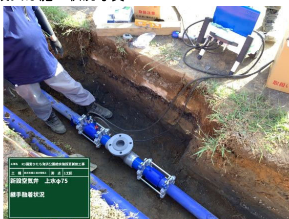
完成又は施工状況写真
