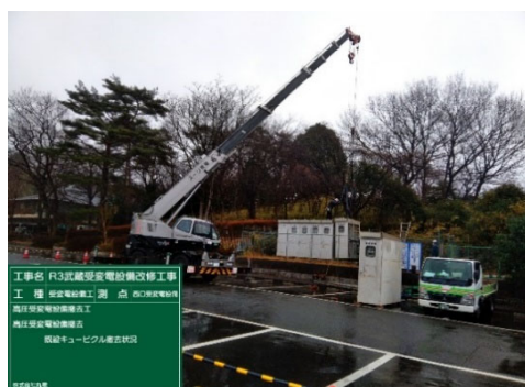
機器撤去の施工状況
