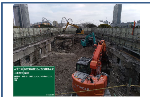
高層棟 階上解体 施工状況
