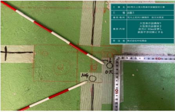
鉄筋探索NG後の施工位置変更
