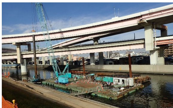
鋼管杭施工状況
