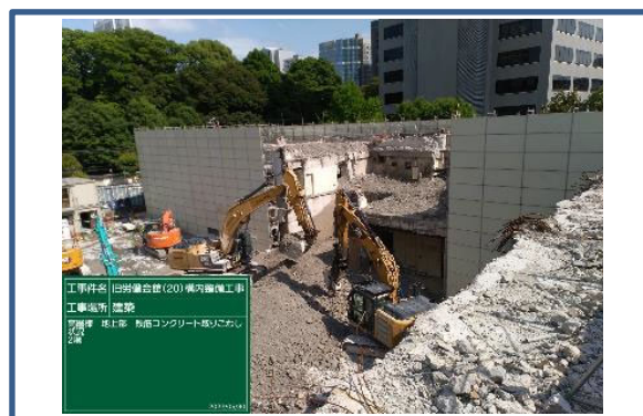
低層棟 地上解体 施工状況
