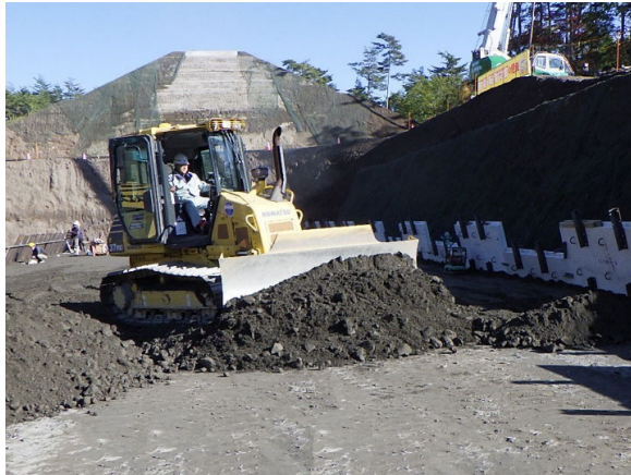
I C T建設機械による施工（MCブルドーザー）
