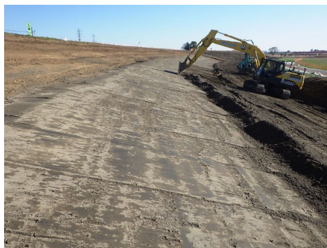
法面整形 施工状況
