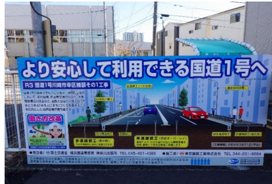
工事PR看板の設置
