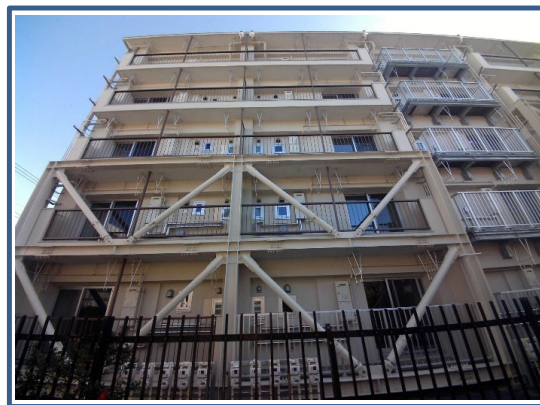
改修後の西側立面 (既存のRC壁を撤去し、ECP壁新設)
