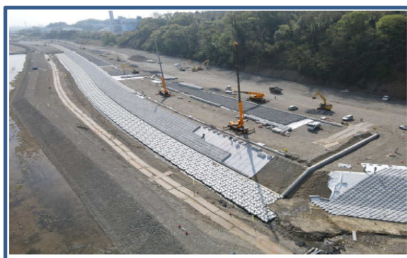
護岸・根固め施工状況
