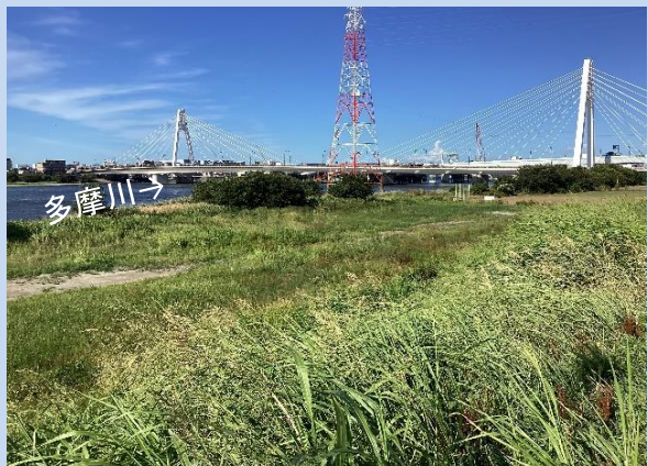
工事着手前 (令和5年9月)
