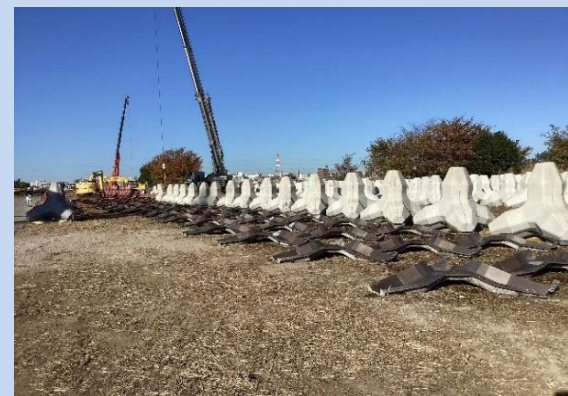
根固めブロックを製作しています。 (令和5年12月)
