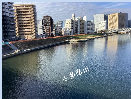
工事に入る準備をしています。 (令和5年10月)
