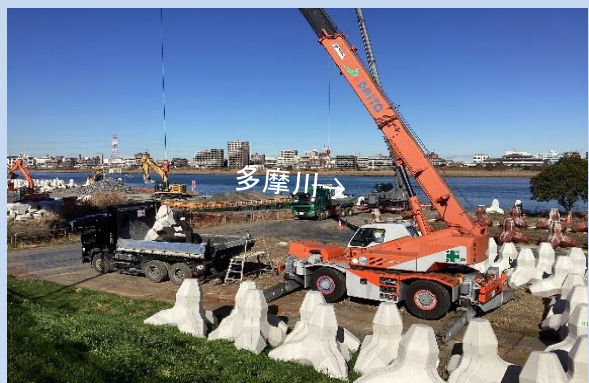
根固めブロックを運搬しています。 (令和6年2月)
