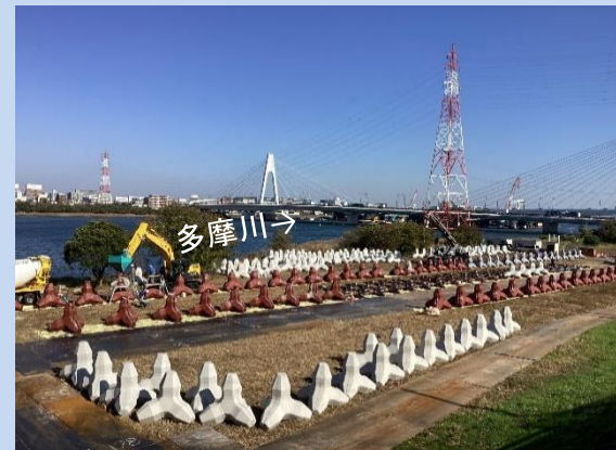
根固めブロックを製作しています。 (令和5年11月)
