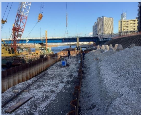
護岸を整備しています。 (令和6年1月)
