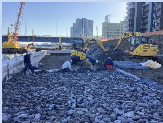
護岸を整備しています。 (令和6年2月)
