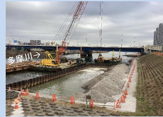
護岸を整備しています。 (令和5年12月)
