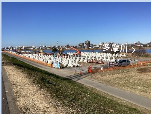
根固めブロックを製作しています。 (令和6年1月)
