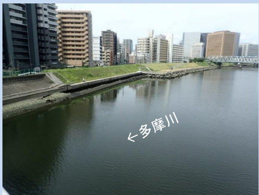
工事着手前 (令和5年9月)
