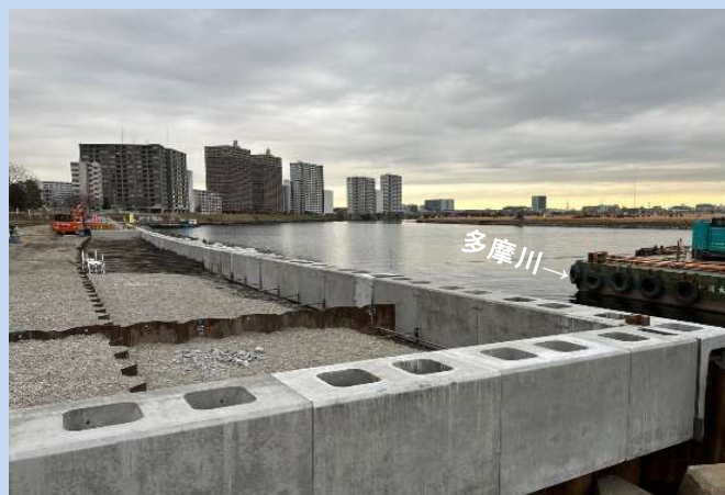
笠コンクリートブロックを設置しています。 (令和6年1月)
