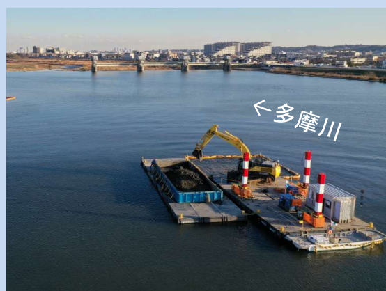
河道を浚渫しています。
