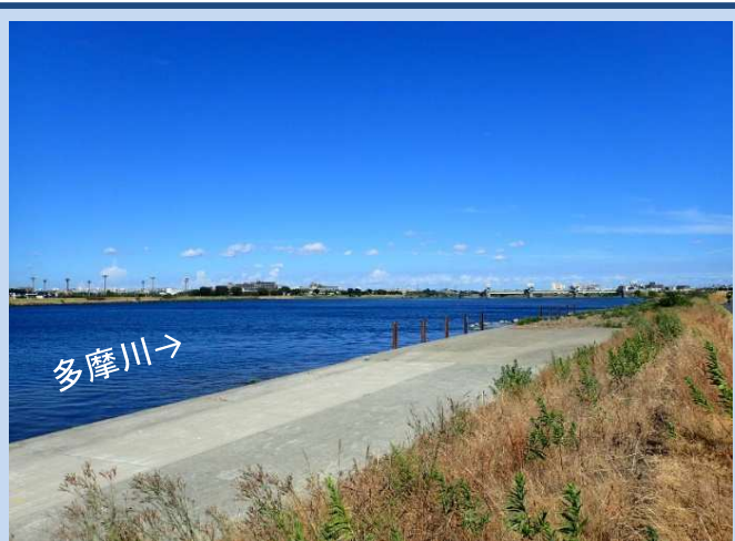
工事着手前 (令和5年7月)
