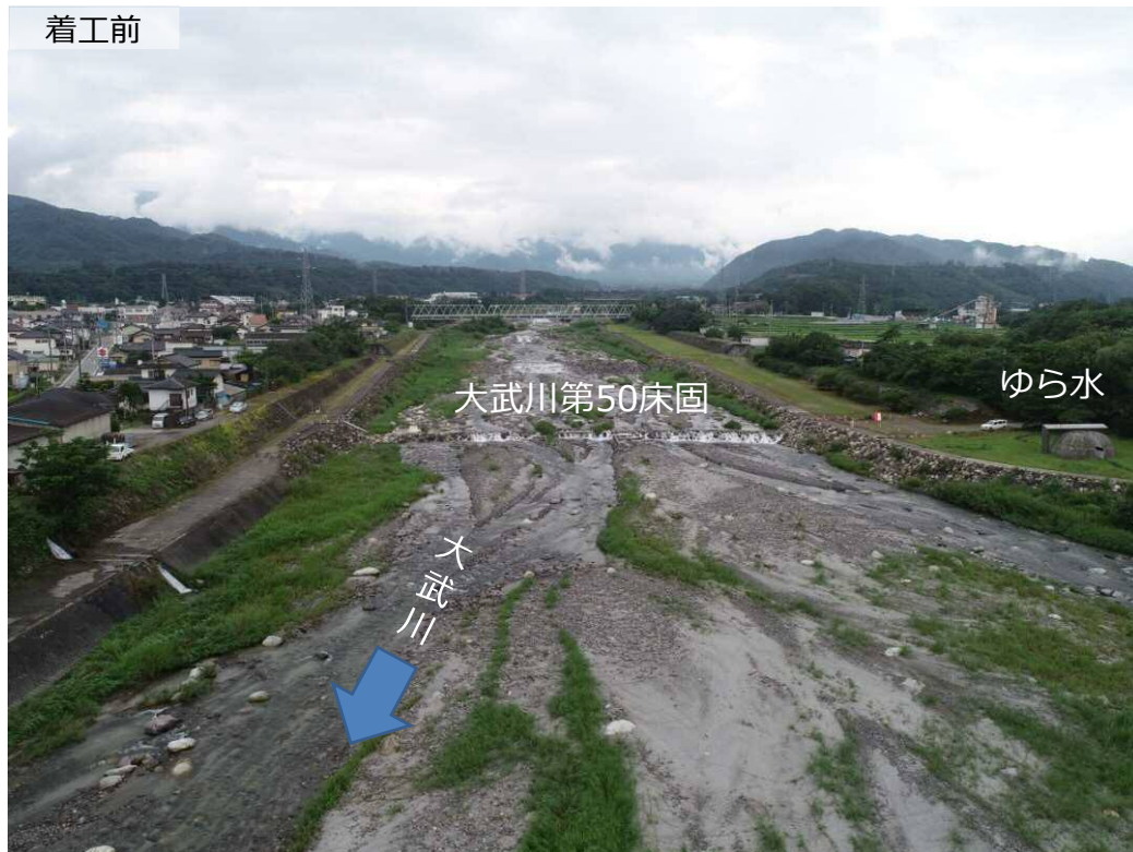
下流側より上流撮影
