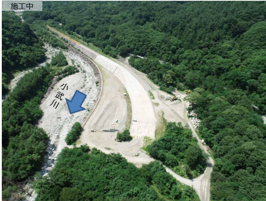
下流側より上流撮影
