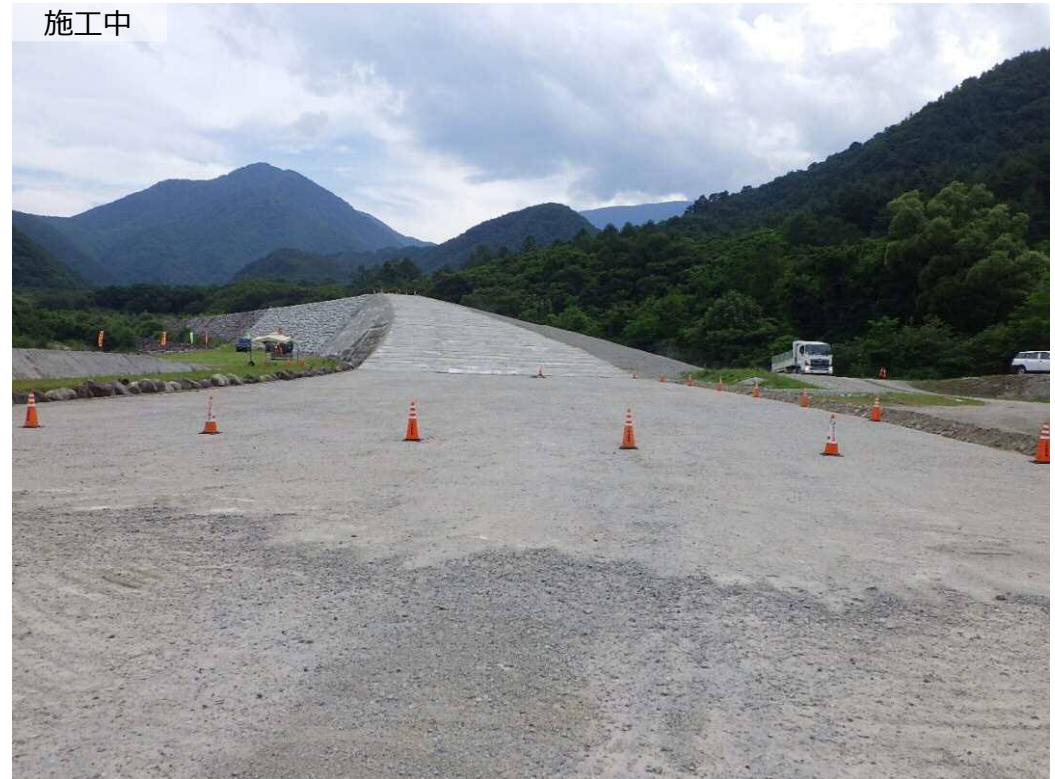
下流側より上流撮影
