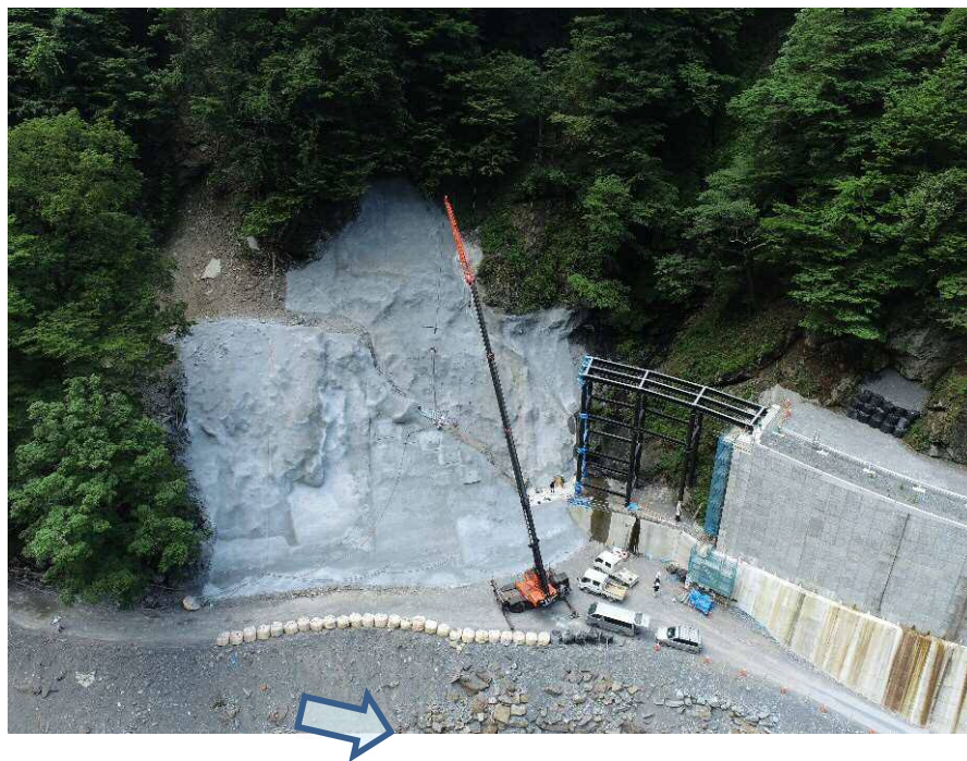
【右岸側上空より施工箇所を望む】
