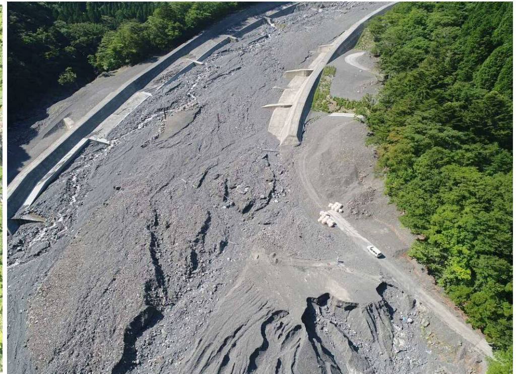
大春木工区 下流側上空より望む
