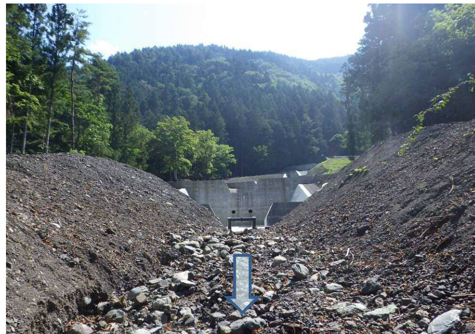
下流側より施工箇所を望む
