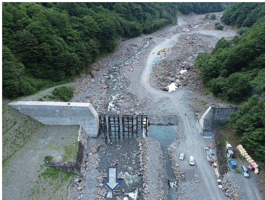
【下流側上空より施工箇所を望む】
