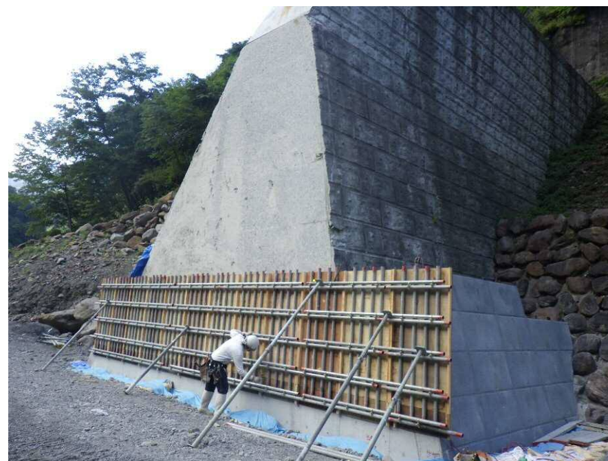
【既設堰堤補強の型枠組立て状況】
