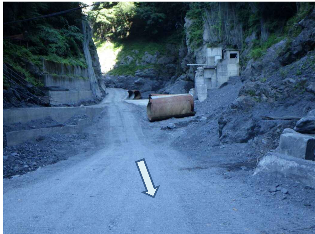
下流側渡河部を望む
