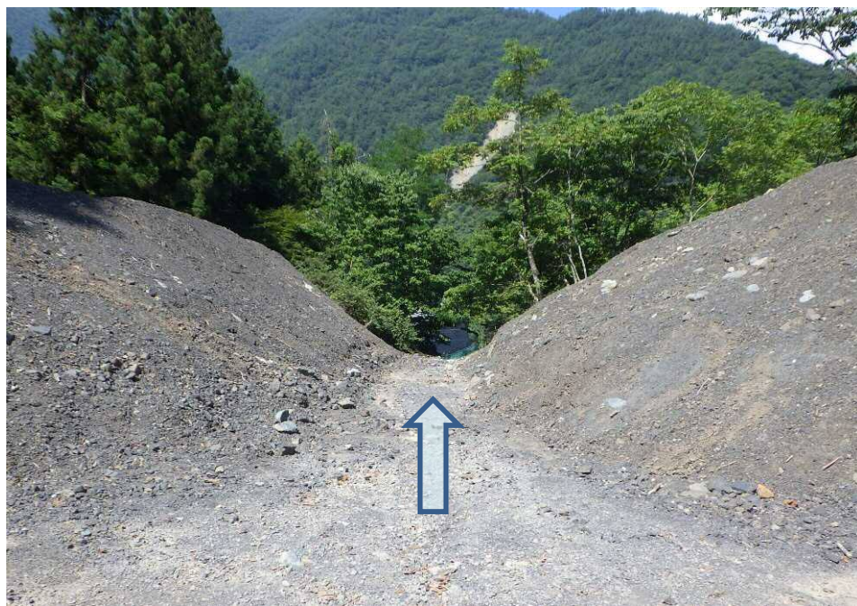
上流側より施工箇所を望む
