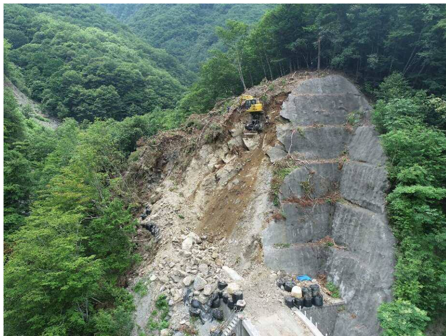
【上空より施工箇所を望む】
