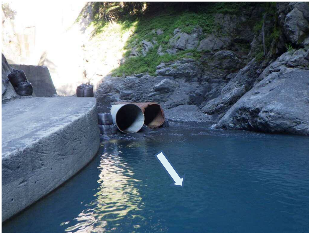
上流側渡河部を望む
