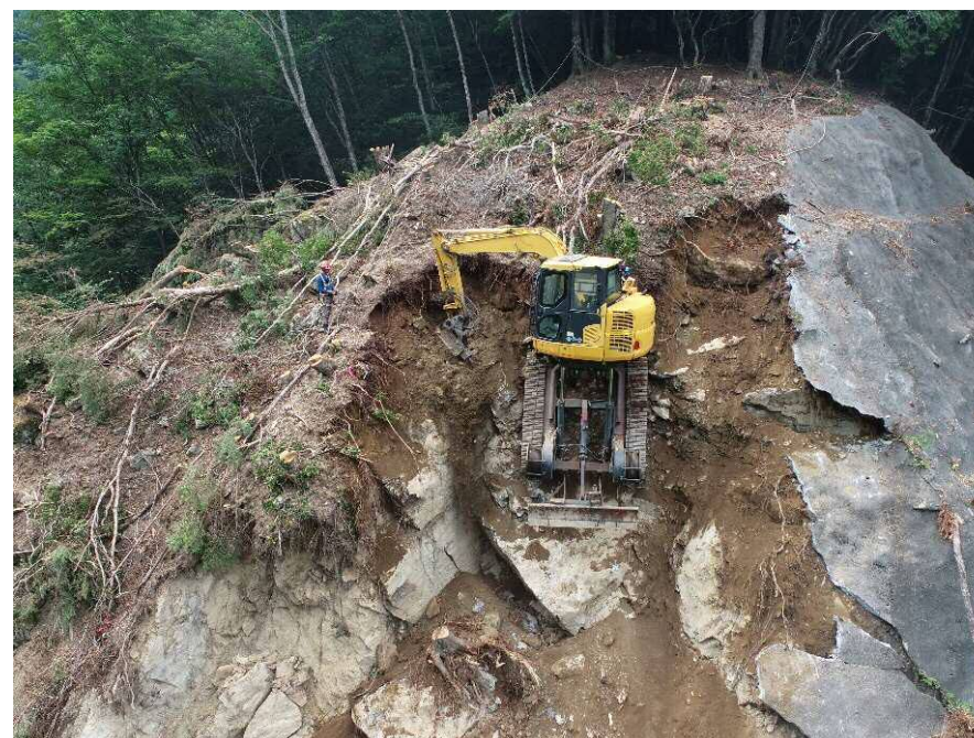
【掘削作業状況】
