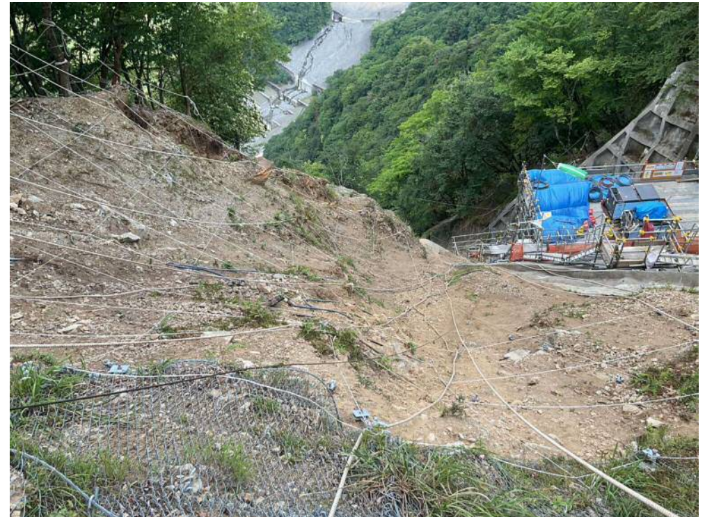
雪害防止網工(厚ネット)施工状況
